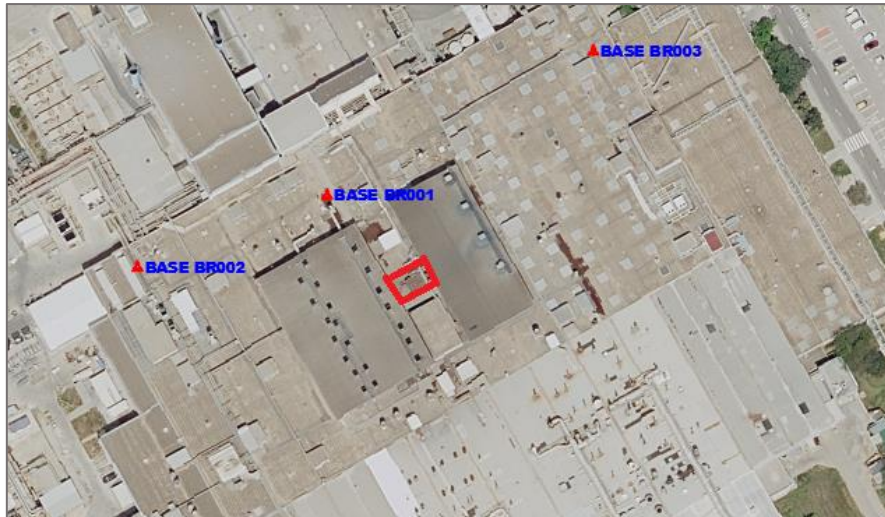
Ilustración 1. Situación centro de transformación (rojo) y bases de coordenadas conocidas. Ilustración propia
