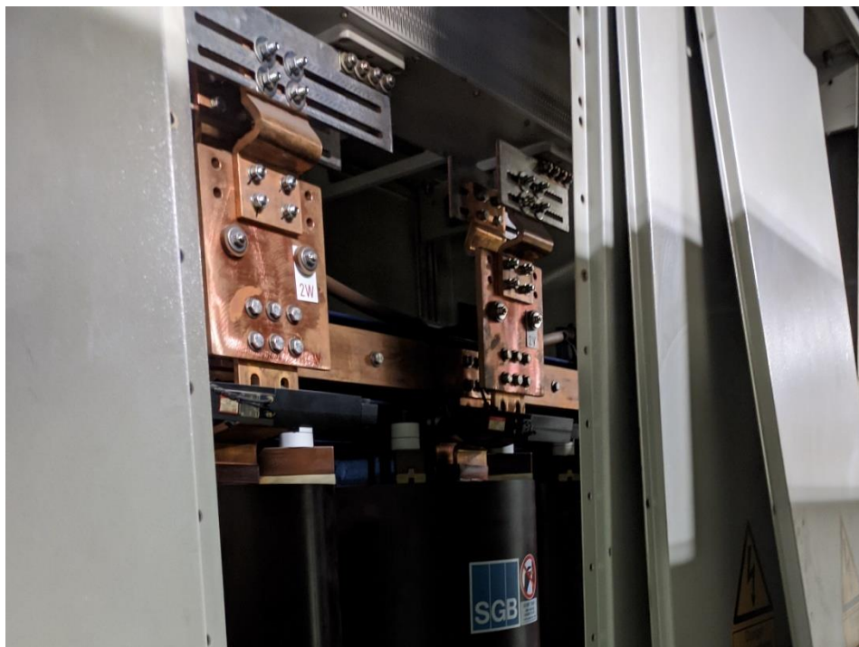
Ilustración 29. Posición de las clemas. Ilustración propia.
