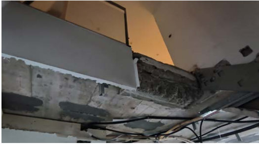
Ilustración 15. Ejemplo derribo escalera. Fuente propia
