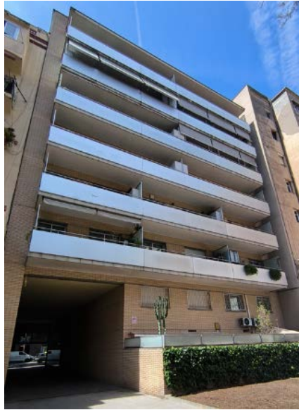
Fotografía 2. Fachada posterior. Fuente propia
