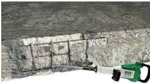
Ilustración 16. Repicado previo. Fuente Generador de precios CYPE
