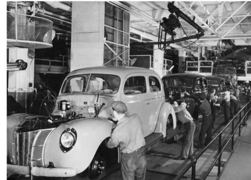
FIG. 56 Fotografía de la cadena de montaje de la fábrica de Ford en Detroit hacia 1939.
