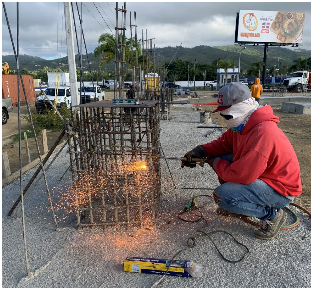
Ilustración 24. Instalación de pernos, supervisión de seguridad al trabajador.
