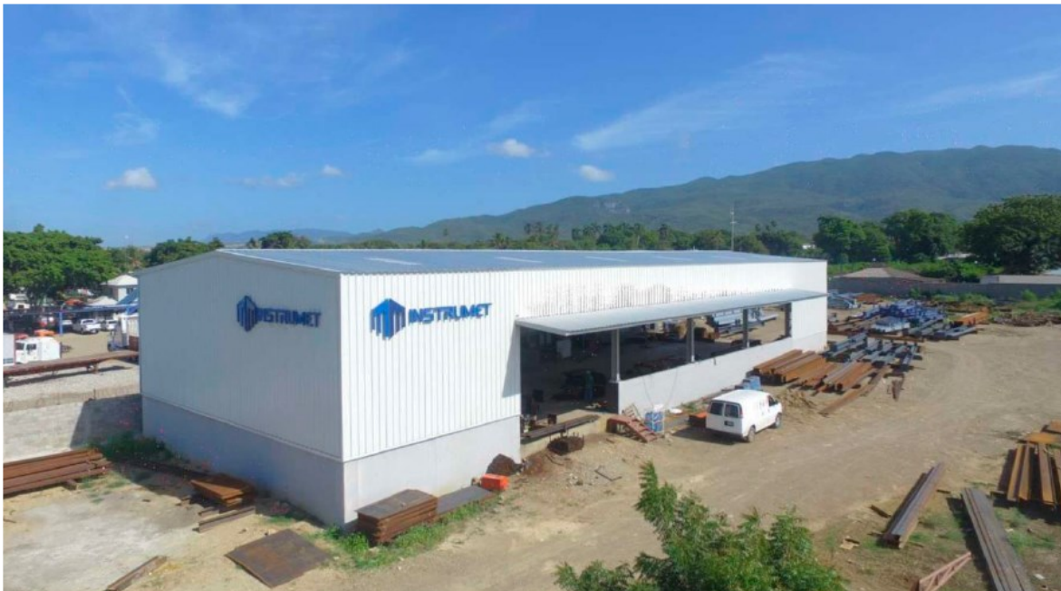
Anexo 4. Planta de producción y área de almacenaje INSTRUMET S.R.L. Fuente: INSTRUMET S.R.L
