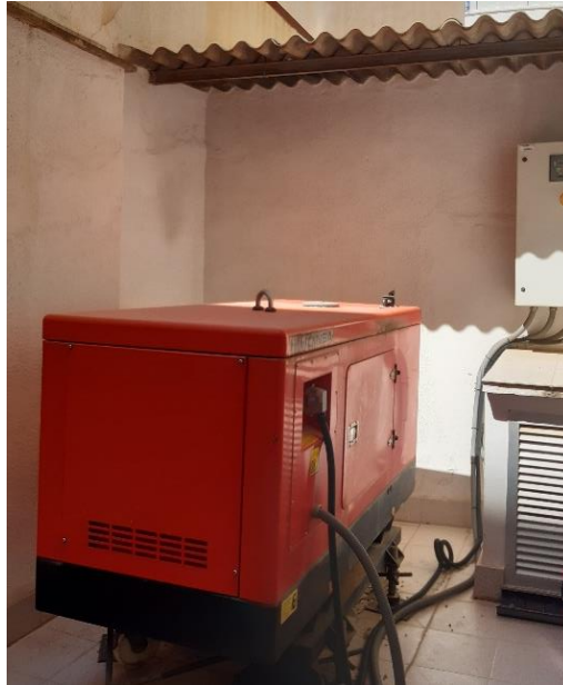
Il·lustració 13 - Grupo electrògeno con su cuadro a modo de control (Elaboración propia, 2023).
