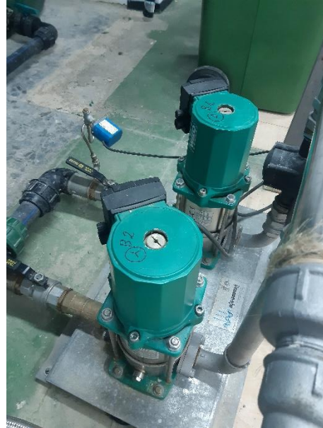
Ilustración 17- Bombas de presión de agua fría (Elaboración propia, 2023).
