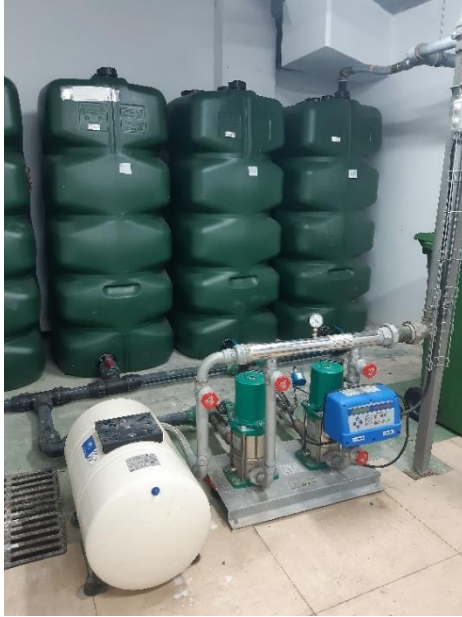
Ilustración 16 – Depósitos, calderín y bombas del grupo de presión de agua fría (Elaboración propia, 2023).
