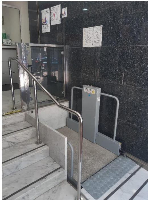
Ilustración 15 - Elevador de carga para personas con movilidad reducida en el Hall (elaboración propia, 2023)
