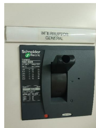
Il·lustració 10 - Interruptor automático omnipolar (Elaboración propia, 2023).
