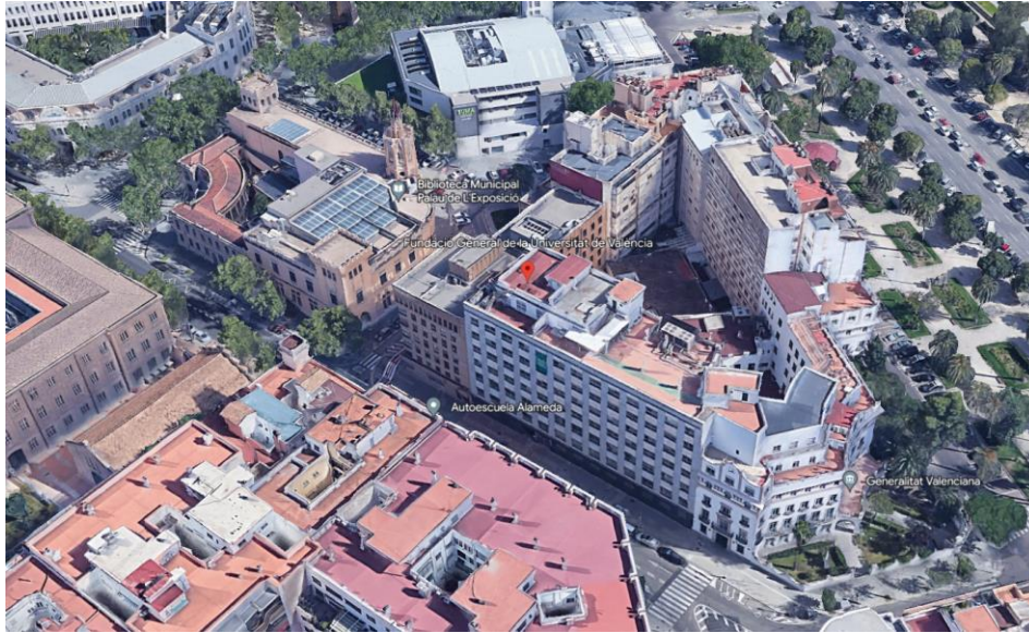
Il·lustració 2 - Vista de satèl·lite del edifici Amadeo de Saboya en València (Google Earth, 2020).
