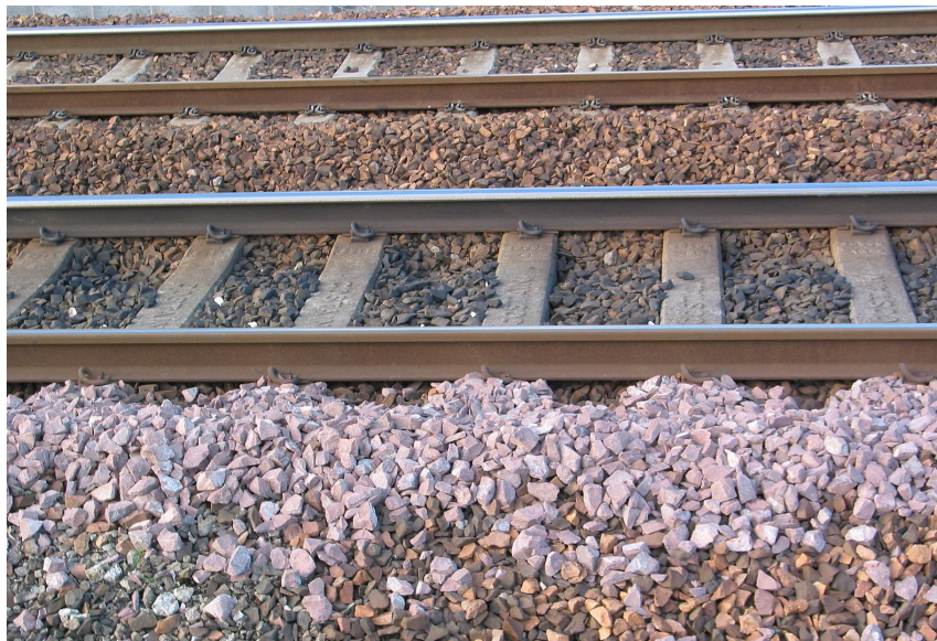
Figura 1: Balasto depositado en las vías. Fuente: Dominio público.
