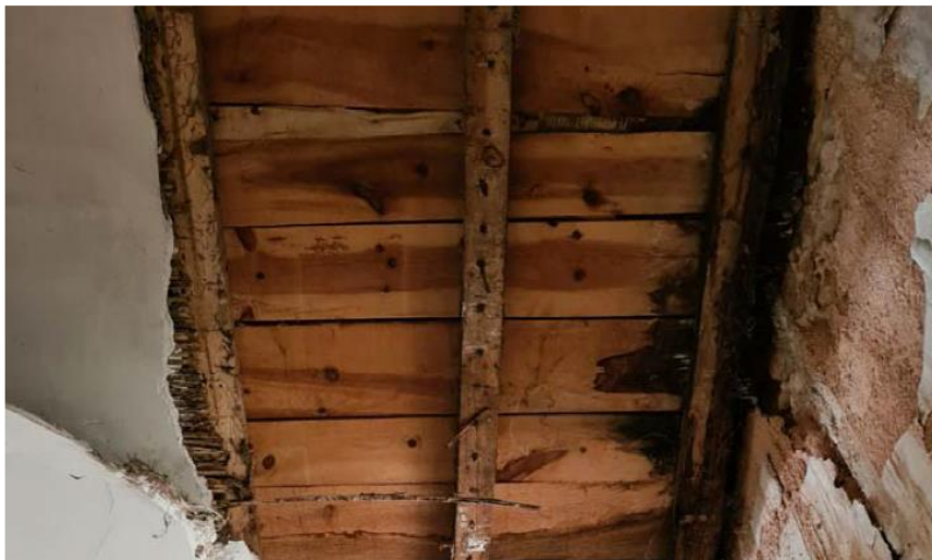
Figura 47. Fotografía del forjado intermedio de madera. 2023. Fuente: propia.
