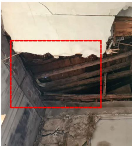
Figura 76. Encuentro vigas de madera de la cubierta con el muro perimetral. 2023. Fuente: propia.
