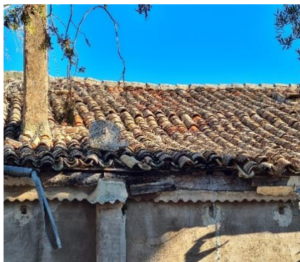
Figura 71. Cubierta con ondulaciones. 2023. Fuente: propia.
