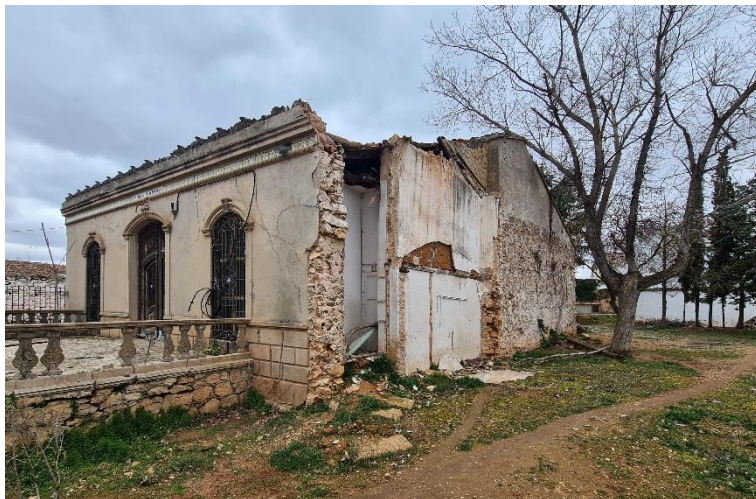
Figura 32. Foto de la vivienda desde el patio. 2023. Fuente: propia
