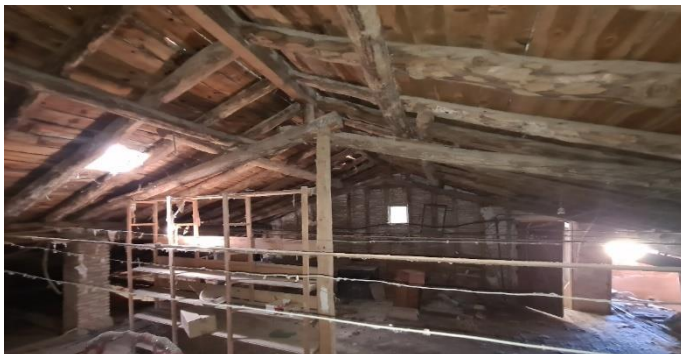
Figura 51. Fotografía de la estructura de cubierta. 2023. Fuente: propia.
