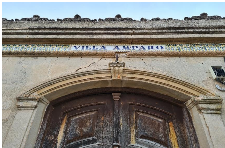
Figura 28. Portada de acceso y nombre de la villa. 2023. Fuente: propia
