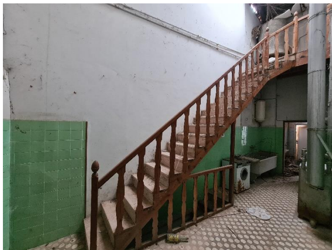
Figura 37. Escalera de subida a la planta primera de cámara. 2023. Fuente: propia
