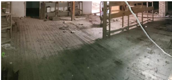
Figura 79. Suelo de la cámara, forjado intermedio de madera. 2023. Fuente: propia.
