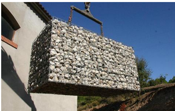
Figura 156. Ejemplo proceso colocación gavión. 2023. Fuente: excavacionesgrasa.com
