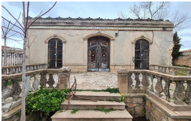
Figura 29. Foto terraza de acceso. 2023. Fuente: propia
