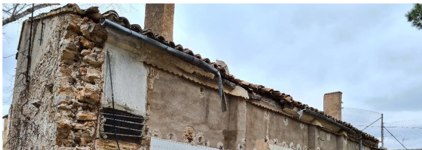
Figura 74. Alero posterior. 2023. Fuente: propia.
