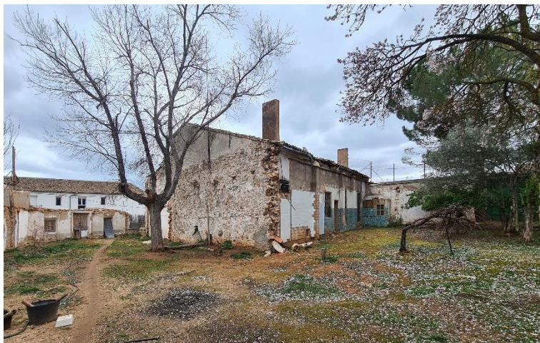
Figura 33. Foto de la vivienda desde el patio. 2023. Fuente: propia
