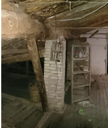
Figura 69. Pilar central en la zona de cámara. 2023. Fuente: propia.
