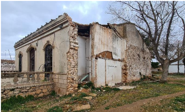
Figura 60. Fotografía general del estado de la vivienda. 2023. Fuente: propia.
