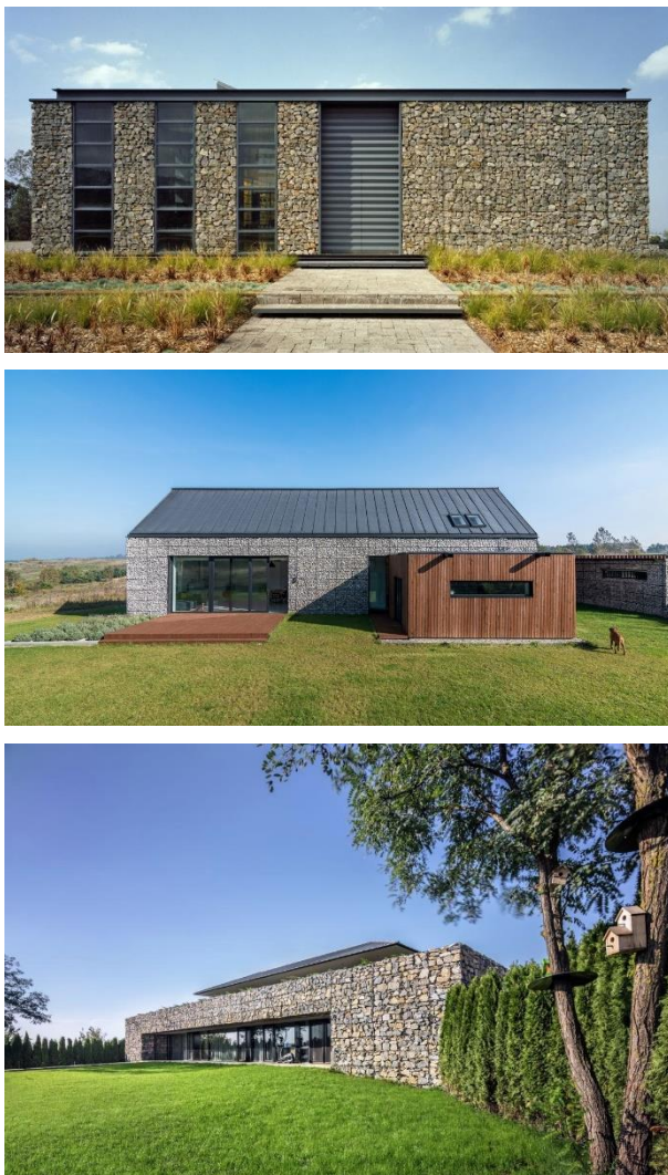
Figura 157. Ejemplos de construcción residencial con gaviones. 2023. Fuente: pacocabello.es
