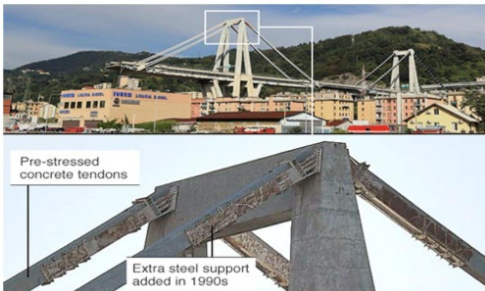
Figura. 9. Detalle de los tendones de hormigón pretensado corroidos. (Fuente: ATP)
