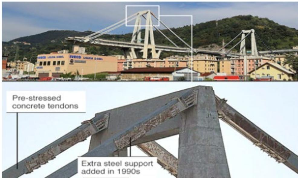
Figura. 8. Detalle de los tendones de hormigón pretensado corroídos. (Fuente: ATP)
