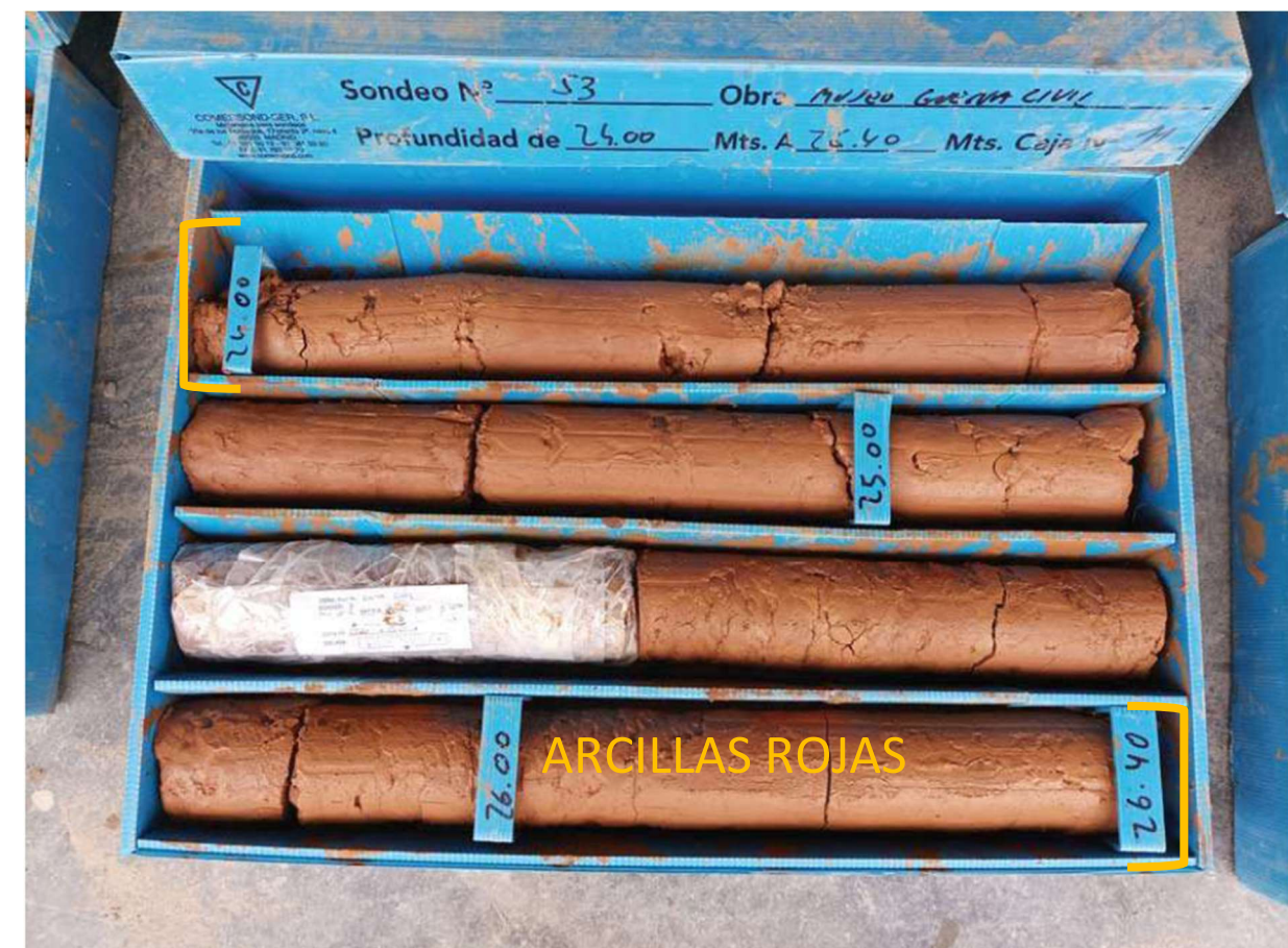
Figura 13. Caja portatestigos. Material a profundidad 24.00 – 26.40 m del S-3 (Fuente: Estudio geotécnico)
