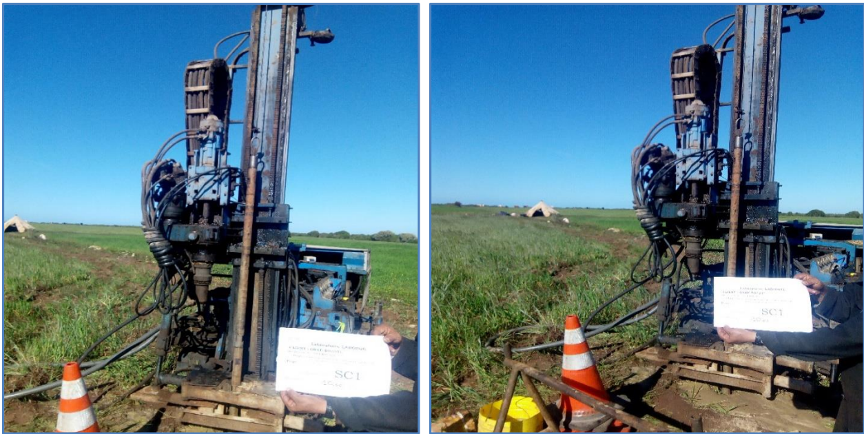
Photos N°7 : Montrant la réalisation du sondage carotté SC1
