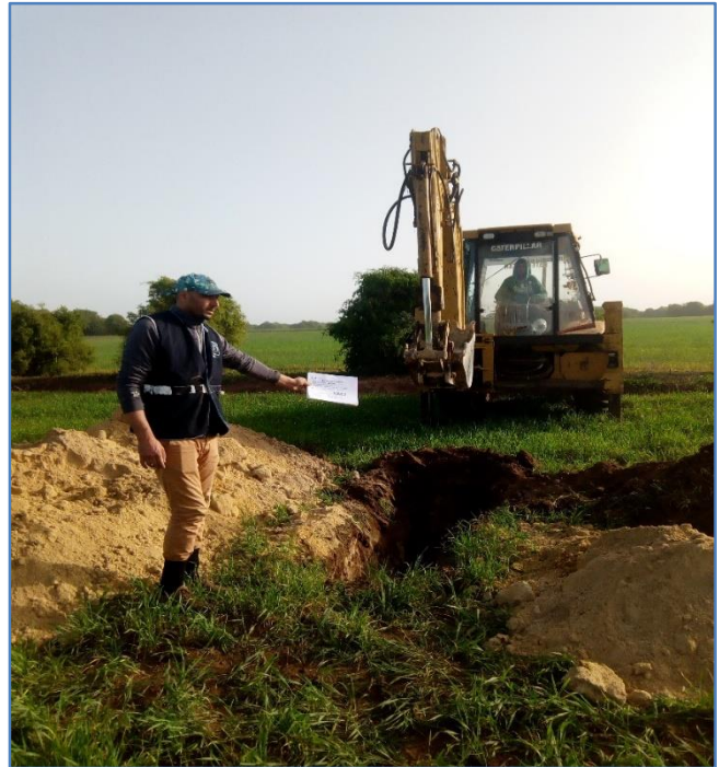
Photo n°5, 6, 7 et 8 : Vue générale du site et la réalisation des sondages manuels de la future station de dessalement
