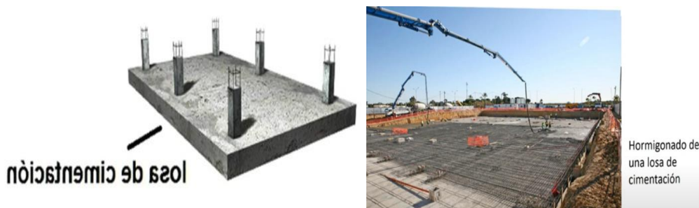
Figura 17: cimentación superficial tipo losa
