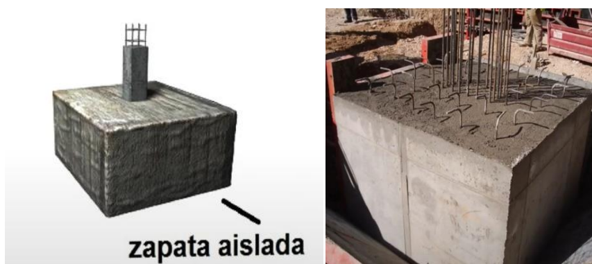
Figura 16: cimentación superficial tipo zapata aislada
