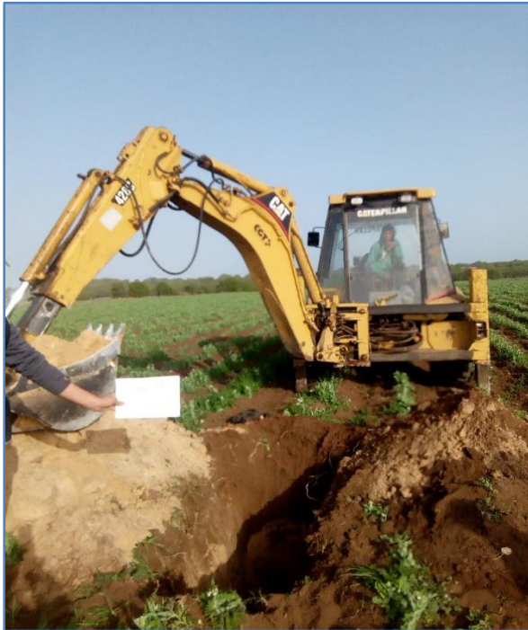
Photo n°5, 6, 7 et 8 : Vue générale du site et la réalisation des sondages manuels de la future station de dessalement
