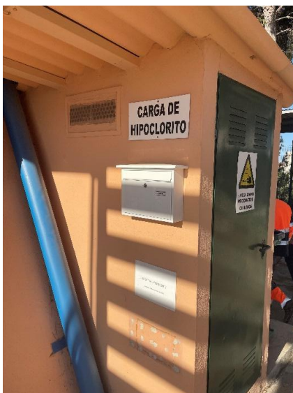
Figura 13: Caseta de carga de hipoclorito, Paterna
