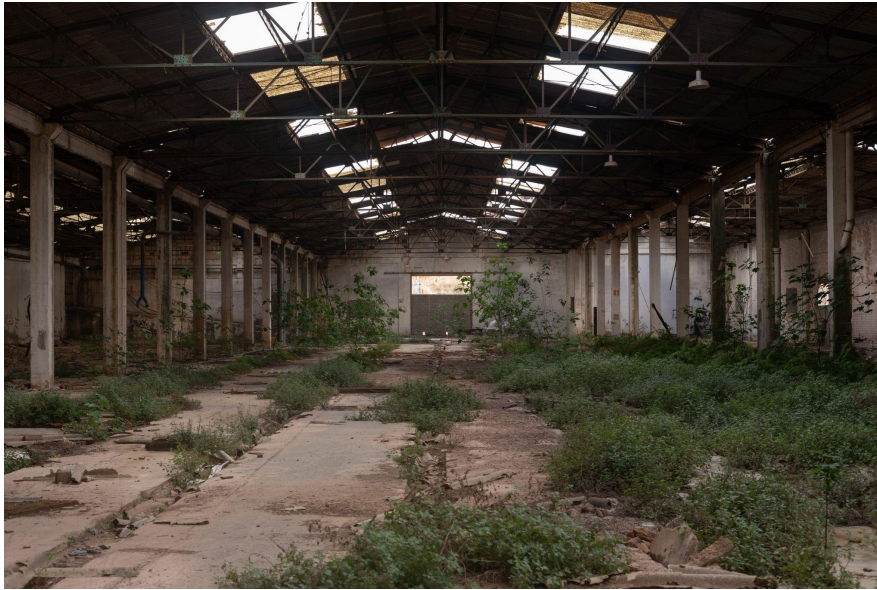
Figura 21.- Localización espacio 1. Fuente: Propia
