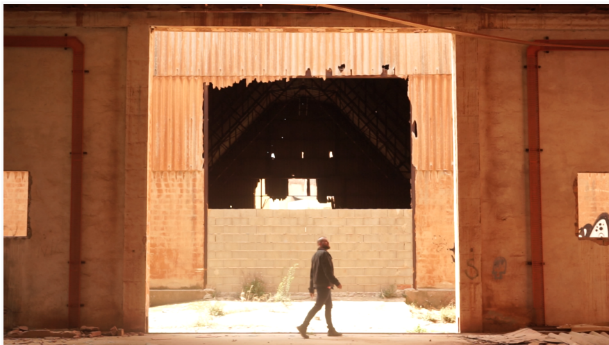
Figura 22.- Localización espacio 2. Fuente: Propia
