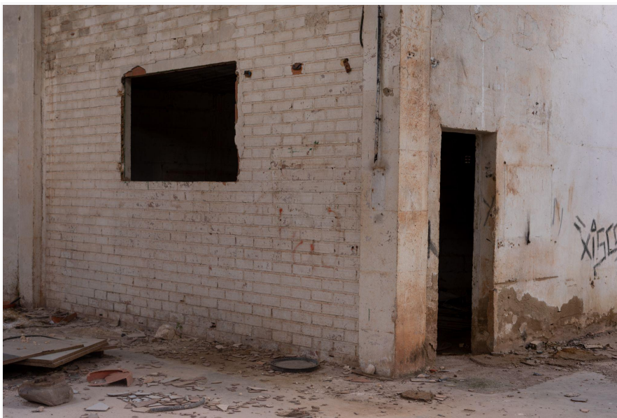
Figura 23.- Localización espacio 3. Fuente: Propia
