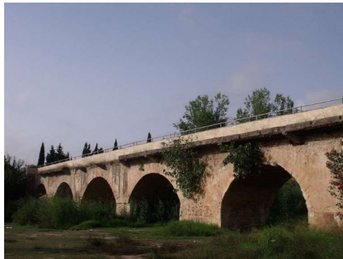
Figura 25: Puente Viejo. Fuente: Portal del Ayuntamiento de Riba Roja.
