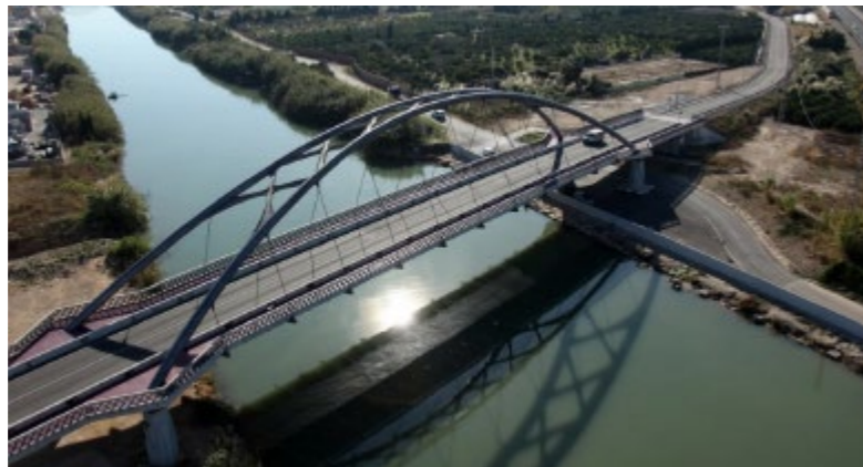
Figura 3.6. Puente tipo Bow-String de Cullera sobre el río Júcar. Autor: Salvador Monleón Cremades
