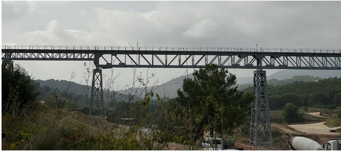
Figura 4.9. Vista del Viaducto del Quisi desde estribo este. Fuente: Elaboración propia
