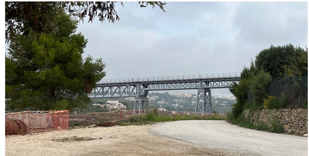
Figura 4.8. Vista del puente desde aguas abajo, estribo este(derecha). Fuente: Elaboración propia
