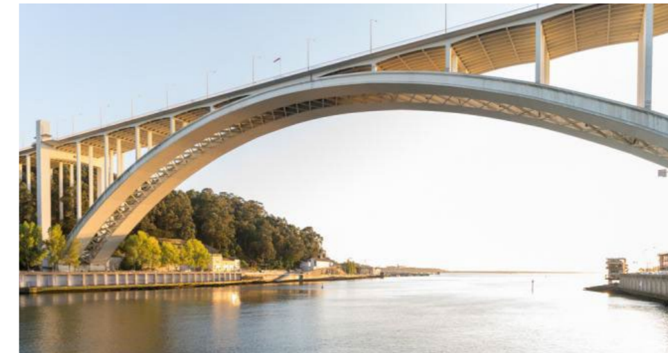
Figura 3.7. Puente de Arrábida tipo arco inferior. Fuente: iStock
