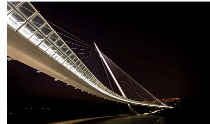
Figura 2.2. Pasarela sobre el río Ebro para la Expo de 2008 en Zaragoza. Autor: Carlos Fernández Casado SL
