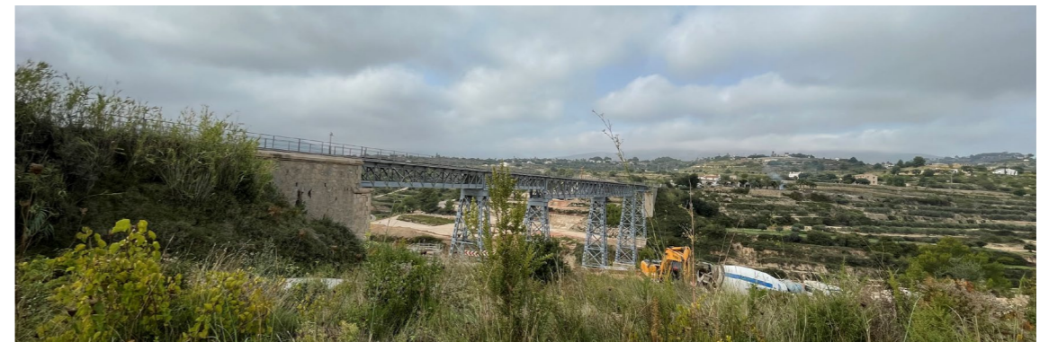
Figura 4.12 Vista desde la entrada de la zona de trabajos del puente (estribo este), desde aguas arriba. Fuente: Elaboración propia
