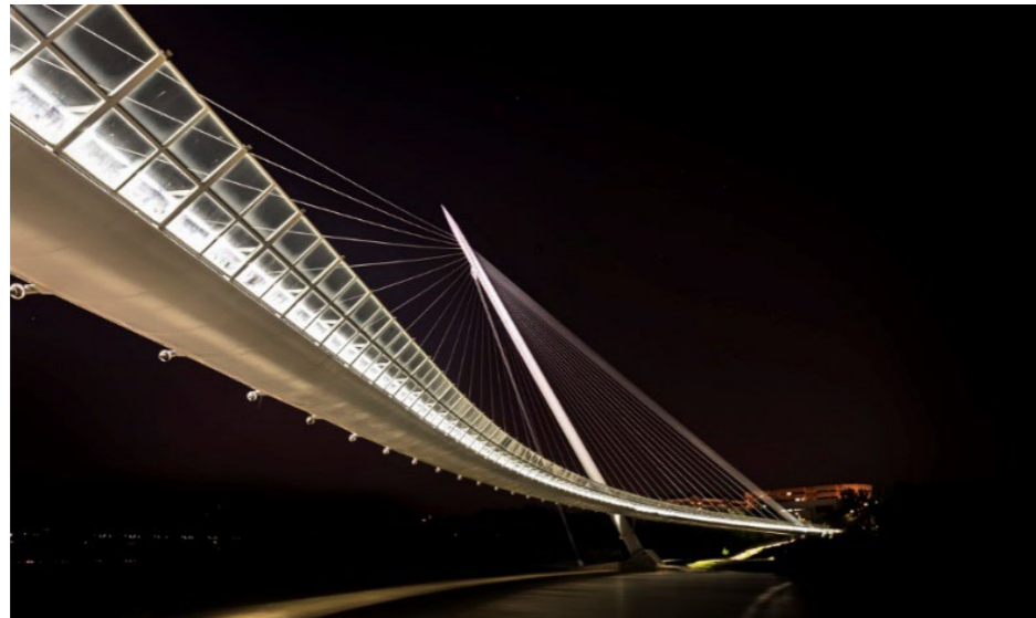
Figura 3.15. Pasarela sobre el río Ebro para la Expo de 2008 en Zaragoza. Fuente: Carlos Fernández Casado SL
