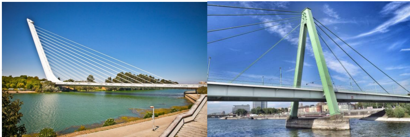
Figura 3.12. Izquierda: Puente del Alamillo en Sevilla (disposición en arpa). Derecha: Puente Severin sobre el Rin en Colonia (disposición en abanico). Fuentes, SevillaSecreta y TripAdvisor
