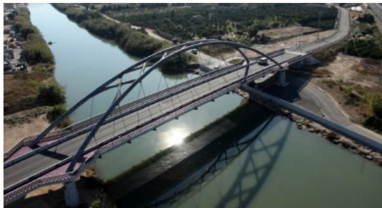
Figura 2.1. Puente arco de tablero de Cullera sobre el río Júcar. Autor: Salvador Monleón Cremades
