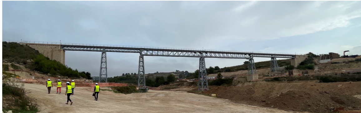
Figura 4.1. Vista general del puente del Barranco del Quisi. Fuente: Elaboración propia
