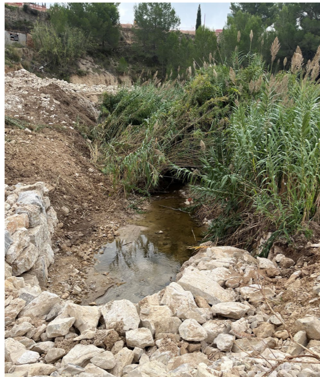
Figura 4.2. Presencia de agua en el emplazamiento. Fuente: Elaboración propia
