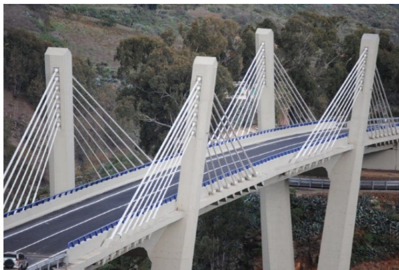
Figura 3.13. Viaducto de Teror en Gran Canaria (solución extradosada). Fuente: Consejería de Obra Pública de Gran Canaria
