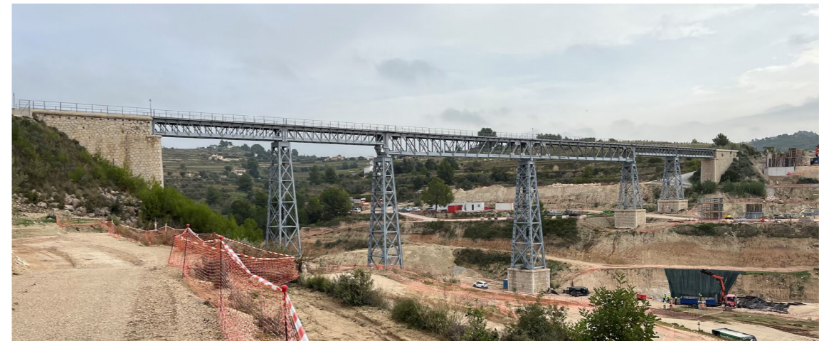
Figura 4.3. Vista del Viaducto del Quisi aguas abajo. Fuente: Elaboración propia
