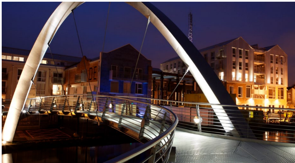
Figura 5.1. Iluminación mediante focos en la pasarela de Electric Wharf. Fuente: Price & Myers 3D Engineering
