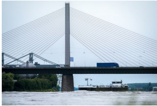
Figura 4.10. Puente Friedrich Ebert ubicado en Bonn (Alemania) en el que se observa el fenómeno de la "Ventana de Homburg". Fuente: Pixabay
