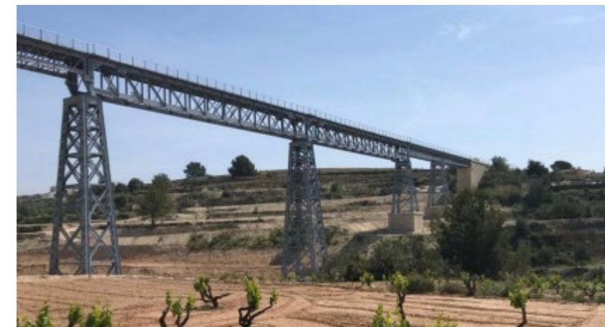
Figura 4.3. Puente del Quisi tras su última rehabilitación. Fuente: FGV
