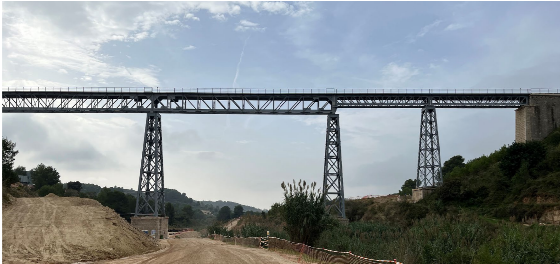
Figura 4.5. Vista de la parte derecha del Viaducto del Quisi desde aguas abajo. Fuente: Elaboración propia
