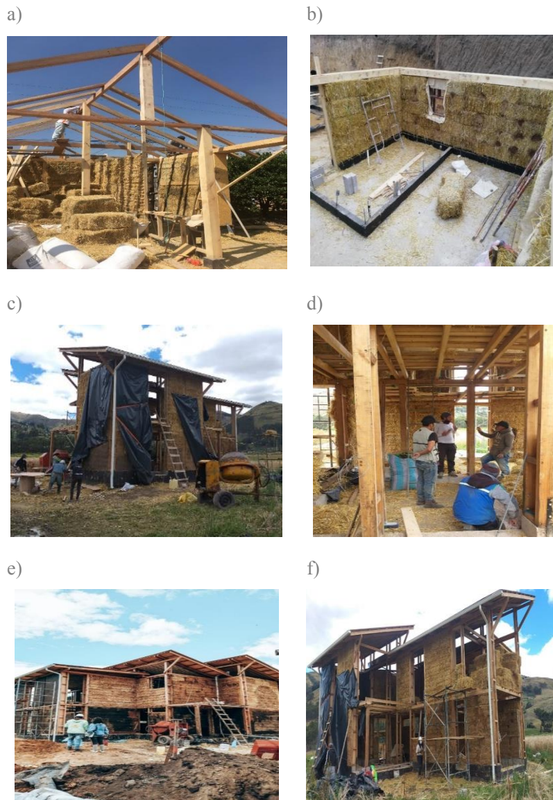
Imagen 1.8. “Construcción del sistema estructural con fardos de paja”.
