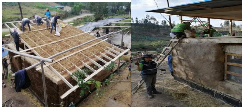
Imagen 6.19. Colocación de cubierta aislada con paja.
