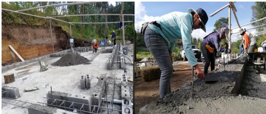
Imagen 6.10. Construcción del sobre cimiento con hormigón y bloques alivianados.
