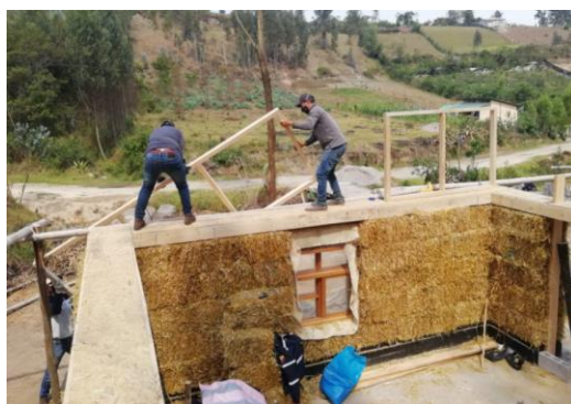
Imagen 3.16. “Construcción autoportante de fardos de paja, Otavalo – Ecuador, 2019”
