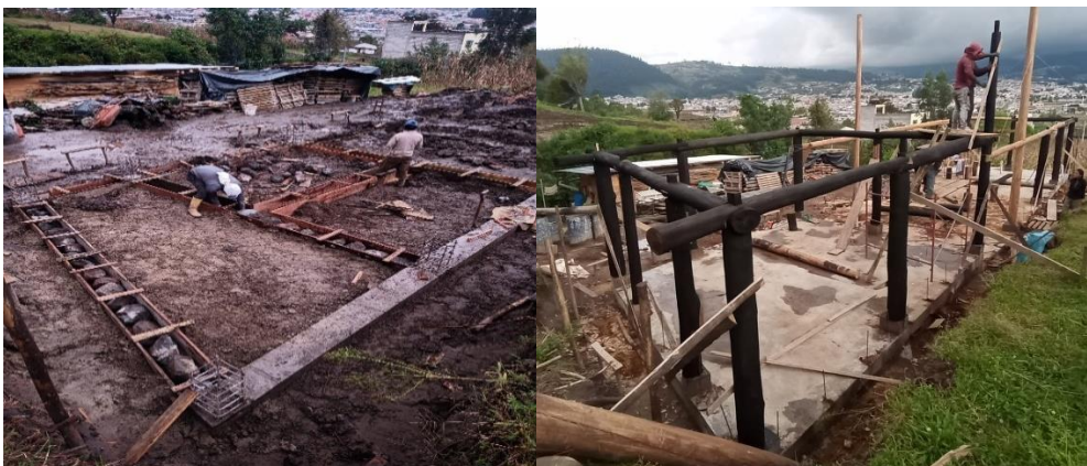
Imagen 6.22. Construcción de la casa Kotama.
