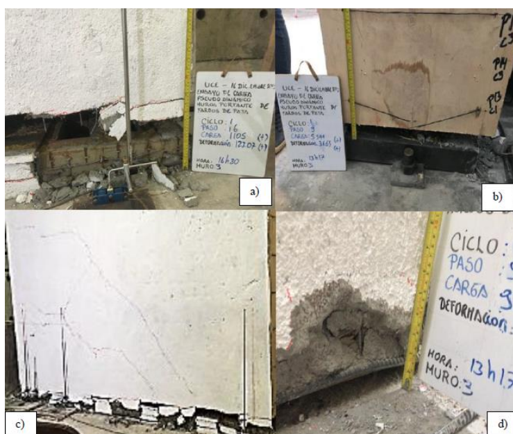
Imagen 5.18. a) Separación del cuerpo del muro de la escalerilla inferior hasta 5 cm. b) vista lateral de la separación del muro. c) Fisuración del muro C. luego del ensayo. d) Deformación de la varilla longitudinal de 12mm.
