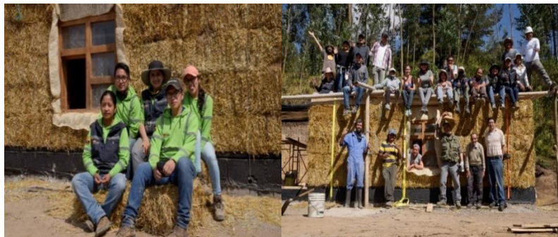
Imagen 6.16. Estudiantes de la universidad central y demás participantes en el levantamiento de los muros en la construcción de la casa “Tamo Wasi” en la provincia de Imbabura.
