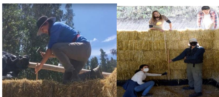
Imagen 6.13. Colocación de estacas entre las hiladas de fardos de paja y demostración de cómo deben colocarse las estacas para que traslapen cada tres hileras.
