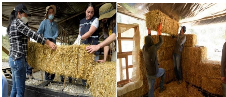
Imagen 6.12. Colocación de la primera hilera de fardos de paja sobre las estacas de madera y levantamiento de los muros portantes.
