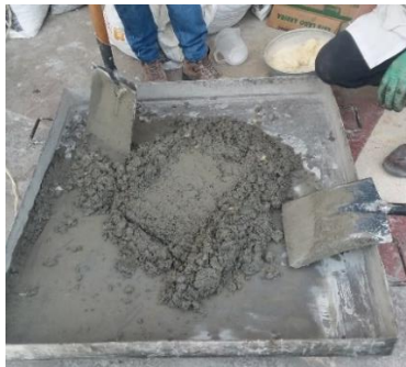
Imagen 4.14. “Mezclado manual del mortero”
