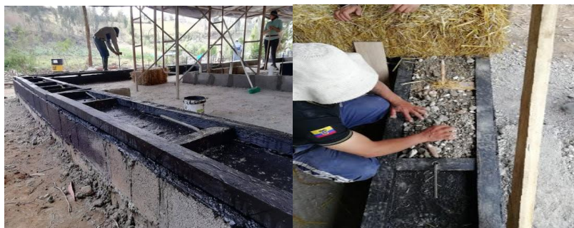
Imagen 6.11. Vista del sobre cimiento con escalerillas de madera encima, pintado con impermeabilizante y colocación del material granular para evitar humedad por capilaridad.
