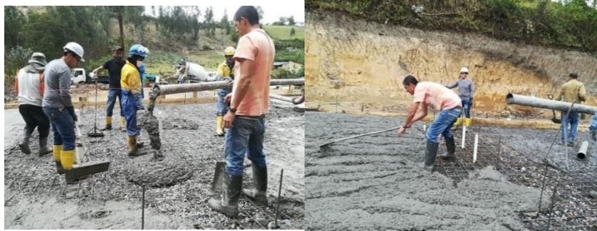
Imagen 6.9. Colocación de hormigón en la cimentación de la casa “Tamo Wasi”.
