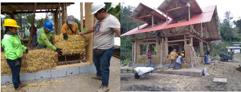
Imagen 6.21. Construcción de vivienda con fardos de paja en Pondoá-Provincia de Tungurahua.
