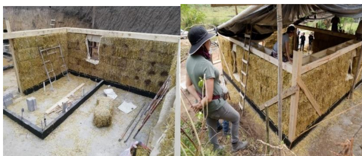
Imagen 6.14. Colocación de vigas perimetrales superiores sobre los muros portantes de fardos de paja.
