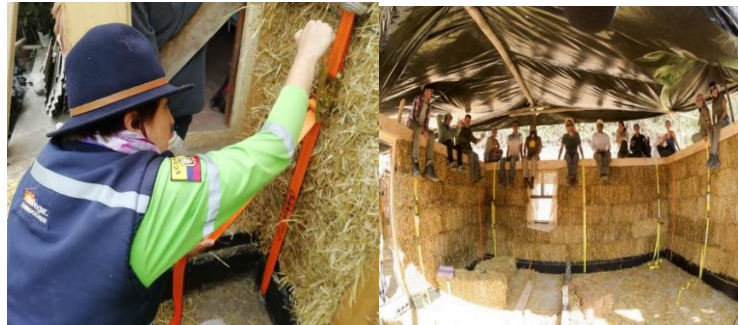
Imagen 6.15. Colocación de las eslingas para comprimir los muros de fardos de paja.
