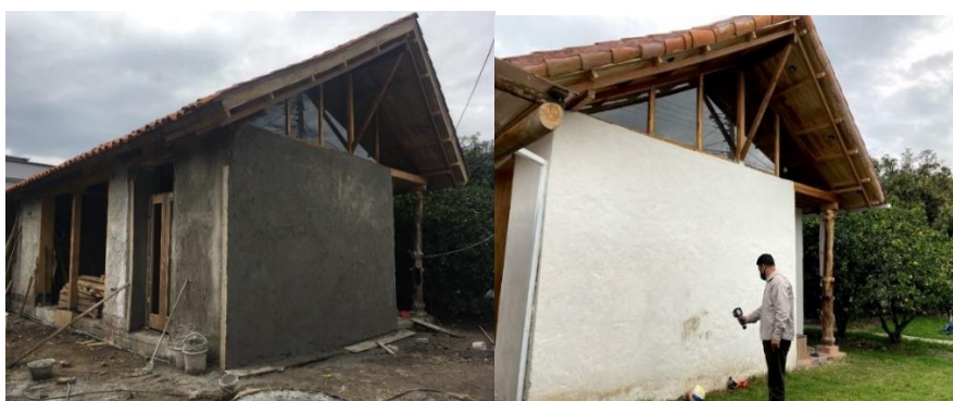
Imagen 6.25. Revocado de muros con barro y cal.
