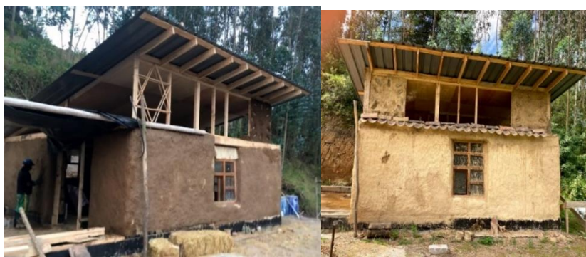
Imagen 6.20. Casa Tamo Wasi con cubierta y revocada.
