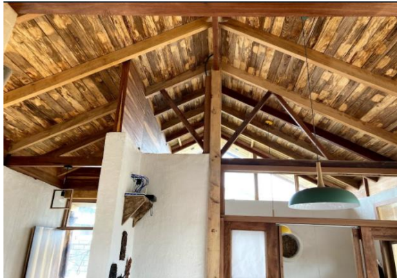
Imagen 3.33. “Cubierta de la vivienda en estudio”
