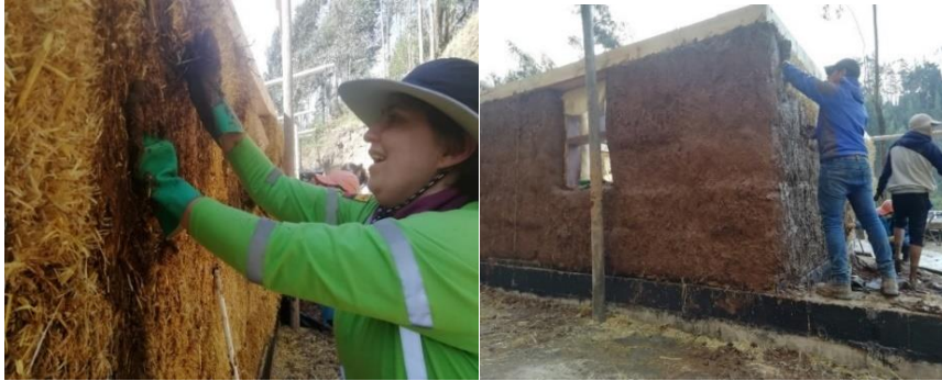
Imagen 6.18. Revocado de las paredes de fardos de paja con barro y cal.
