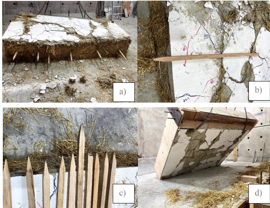
Imagen 5.20. a) Estacas inferiores del muro. b) Estaca de unión intacta. c) Grupo de estacas internas sin presencias de daños. d) Desmontaje del muro D.
