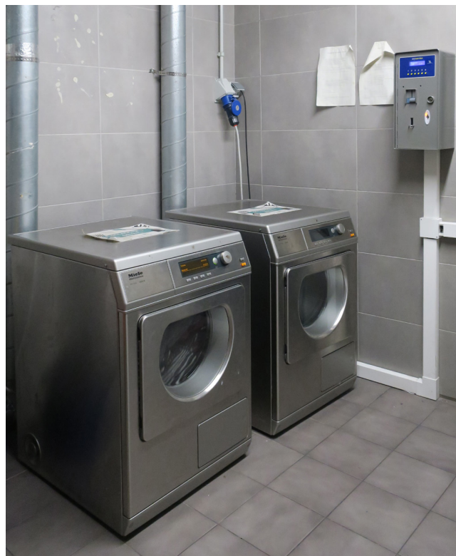
Figura 40. Lavandería automática de Generator .
