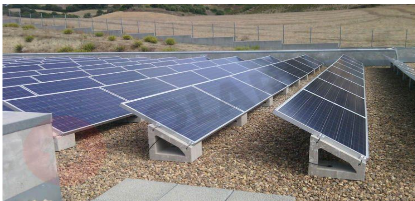
Figura 16 : Sistemas de montaje con bloques de hormigón
