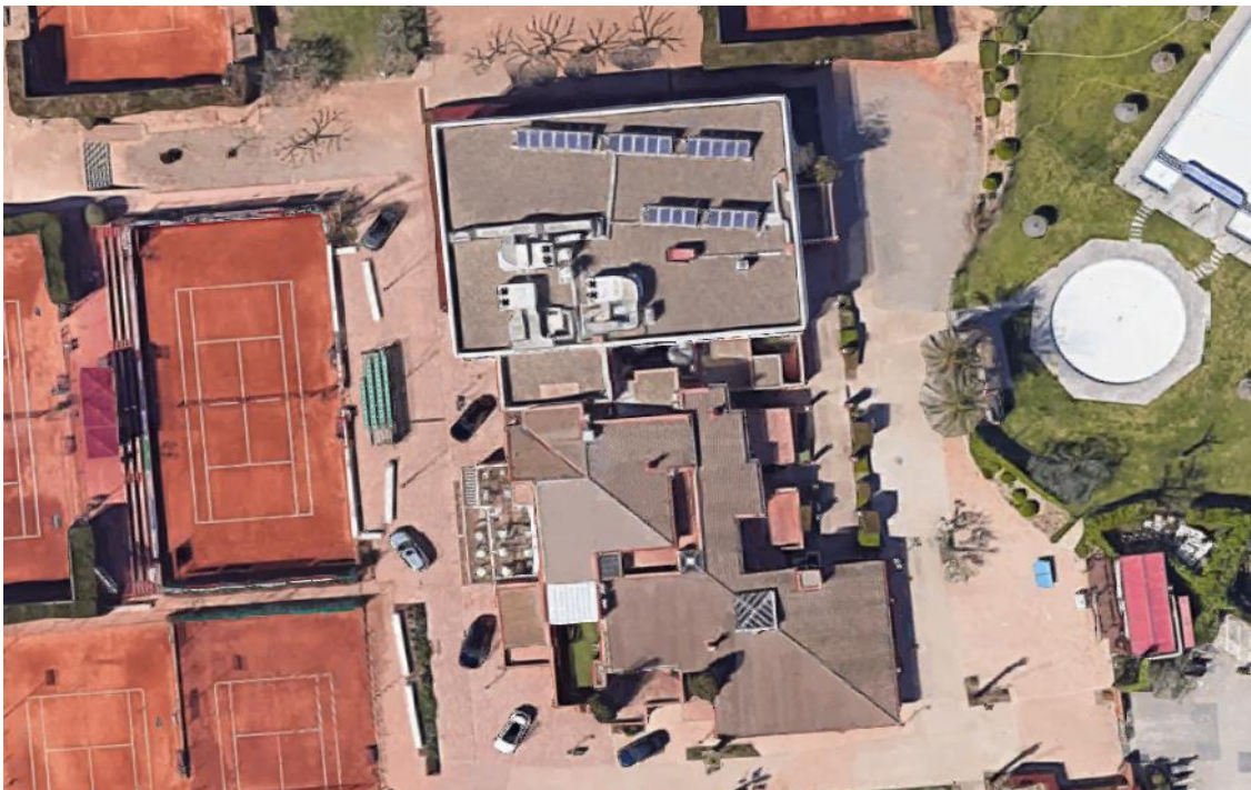
Ilustración 4: Cubierta de las instalaciones de Club de Tennis Reus Monterols. Fuente: Google Maps.
