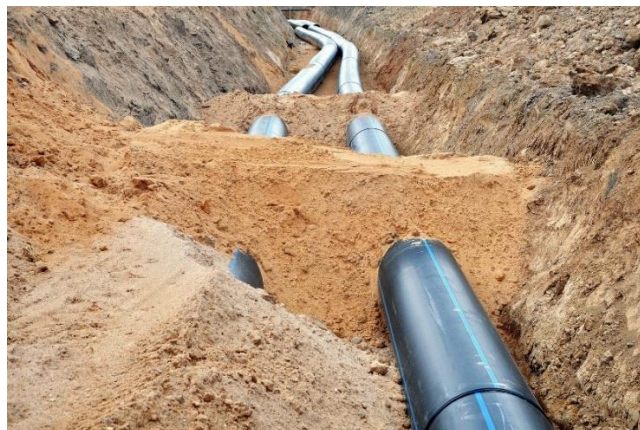
Ilustración 11: Ejemplo de zanja en el terreno
