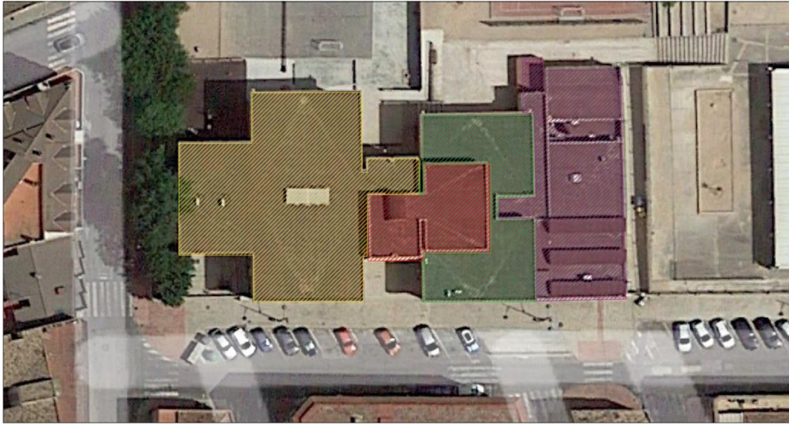
Cubierta 1 Cubierta 2 Cubierta 3 Cubierta 4
