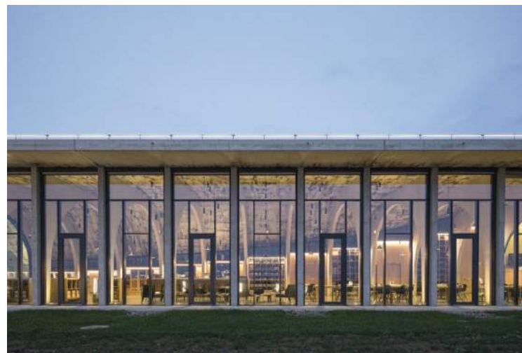
Figura 35. Exterior, bodega Lahofer. Fuente: Arquine.
