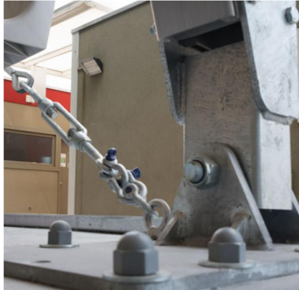
Figura 36. Placa de anclaje Tipo 2. https://okatent.com/fijaciones/
