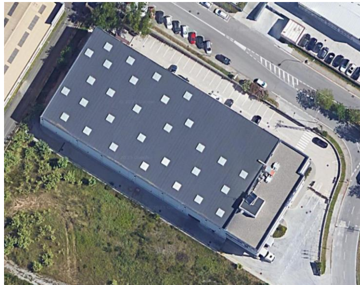
Figura 3. Tejado en donde se desarrollará la instalación (Google Maps)
