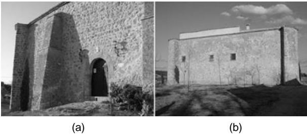
Figura 9: La Fortaleza de Torre de Don Morant, hoy Torrebuceit: a) Vista parcial del alzado sur, acceso; b) Vista del alzado oeste.
