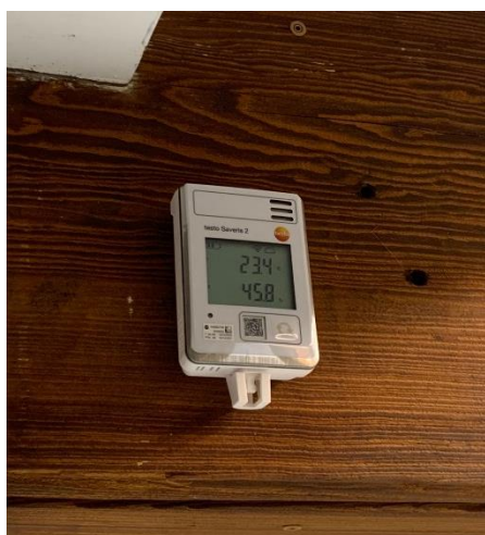
Imagen 22: Termohigrógrafo de la sala de reserva. Fuente: Elaboración propia, 2023.
