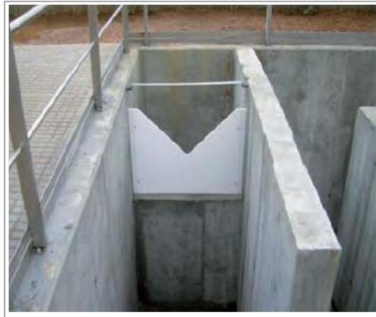
Figura 1. Vertedero triangular para medición de caudal. Fuente: (CEDEX, 2010).
