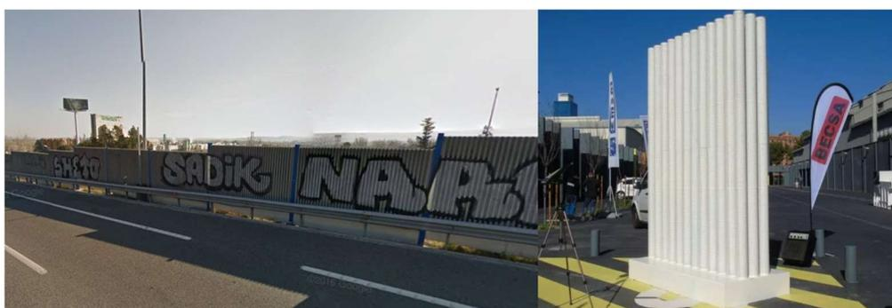
*Figura 7 – A la izquierda: barrera acústica tradicional de ocultación, a la derecha: pantalla acústica basada en CS [9][22]*
