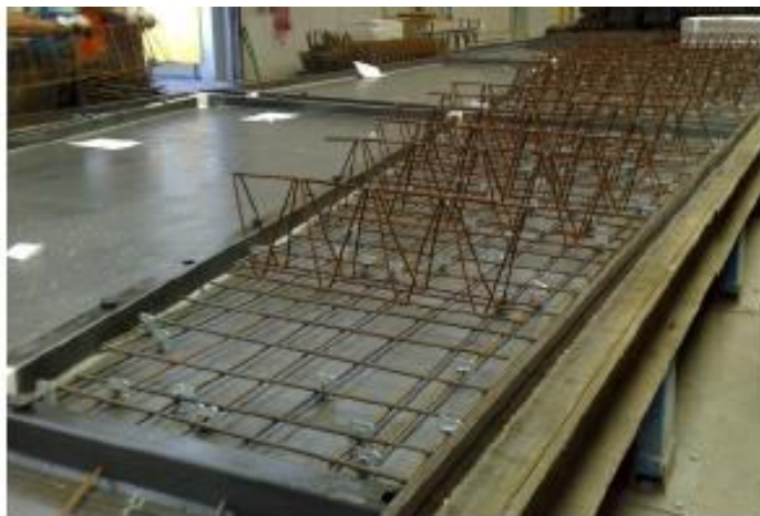
Ilustración 63. Colocación del armado. www.prefabricadoscanal.com
