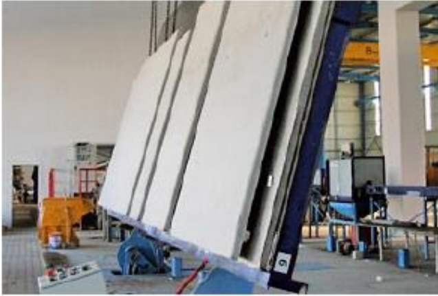
Ilustración 68. Desmolde de muro. www.prefabricadoscanal.com
