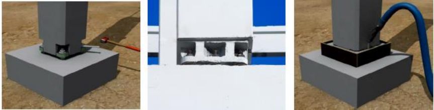
Ilustración 78. Proceso montaje pilar. www.prefabricadoscanal.com
