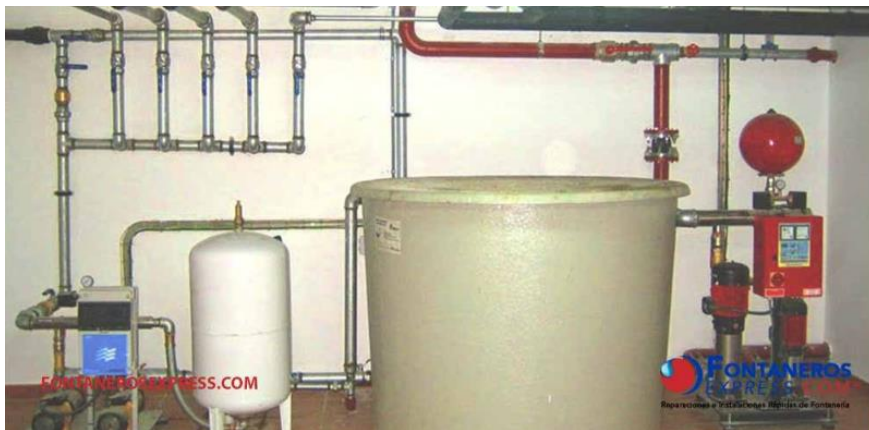
Ilustración 13. Grupo de presión. www.blogsaverroes.juntadeandalucia.es
