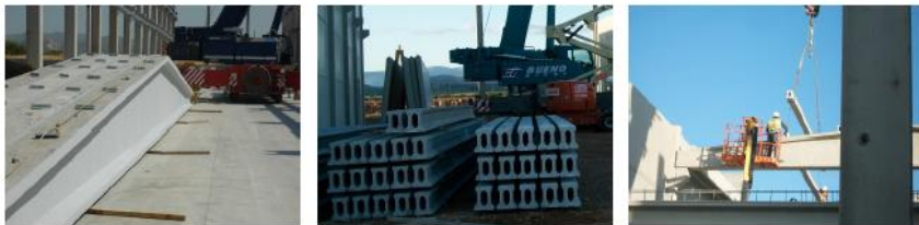
Ilustración 74. Posicionar anclaje en viga, acopio y montaje correas. www.prefabricadoscanal.com
