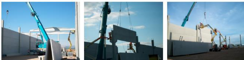
Ilustración 75. Acopio, posicionamiento. www.prefabricadoscanal.com
