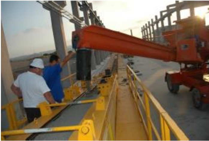
Ilustración 64. Vertido de hormigón en molde. www.prefabricadoscanal.com
