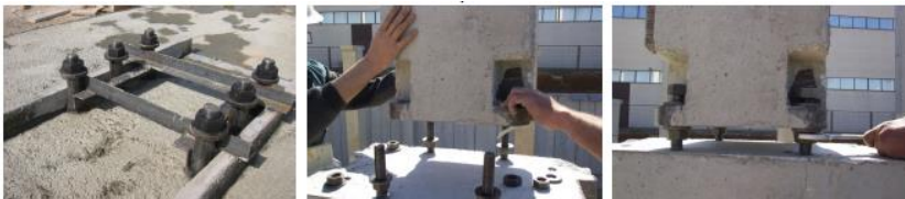
Ilustración 77. Proceso montaje pilar. www.prefabricadoscanal.com
