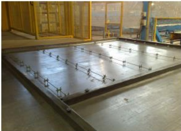
Ilustración 61. Colocación costeros imantados www.prefabricadoscanal.com
