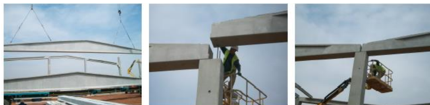
Ilustración 73. Manipulación, posicionamiento y montaje de viga. www.prefabricadoscanal.com
