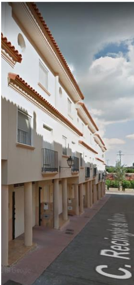
Imagen 6: Edificio tipo. Fuente Google Maps
