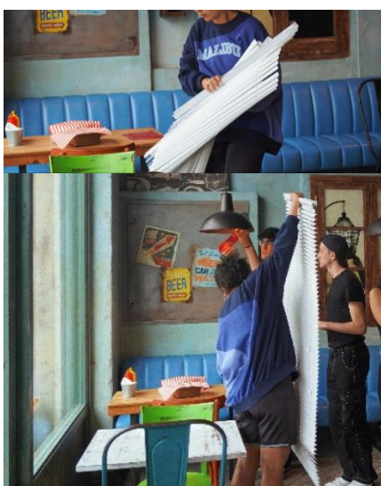
Figura 62. Colocación de la veneciana
