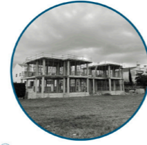
3 Vivienda unifamiliar en construcción
