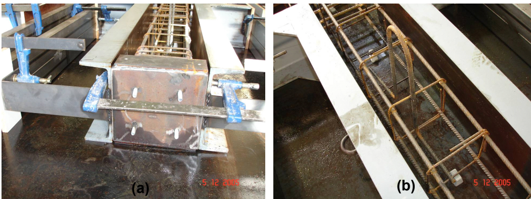
Fig. V.2. Ferrallado de las probetas. (a) Elemento metálico en los extremos de las probetas formado por perfiles UPN-260; (b) Horquilla de acero corrugado para posterior izado de las probetas
