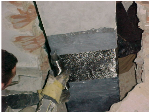
Fig. 2.1. Ejecución de un refuerzo mediante FRP
