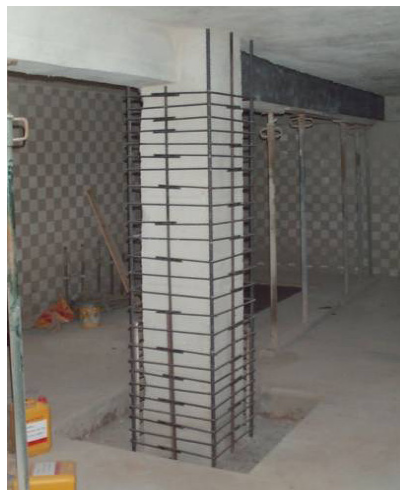
Fig. 2.2. Ferrallado dispuesto para el encofrado y hormigonado de un recrecido de hormigón
