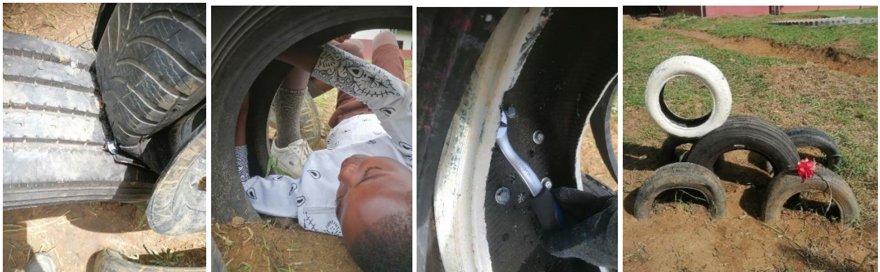
Ilustración 178: Rotura rueda y fijación nueva cabeza elefante. Fuente: Propia.
