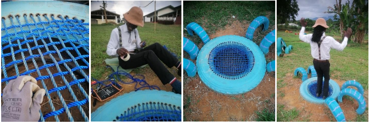
Ilustración 189: Colocación cuerda araña azul. Fuente: Propia.
