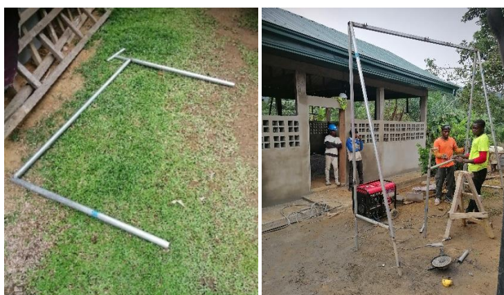
Ilustración 83: Soldadura estructura calculadora. Fuente: Propia.
