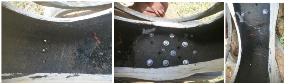
Ilustración 180: Tornillos cabeza elefante y agujeros agua lluvia. Fuente: Propia.
