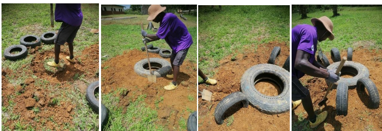
Ilustración 185: Enterramiento ruedas araña. Fuente: Propia.
