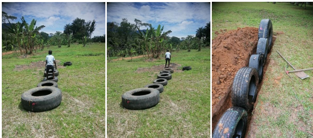
Ilustración 141: Ubicación y enterramiento de neumáticos serpientes. Fuente: Propia.
