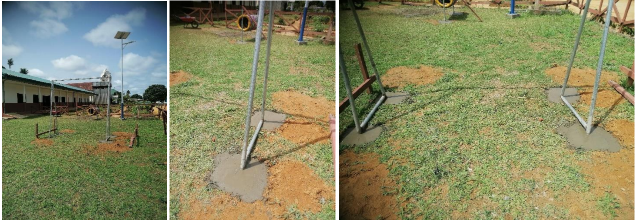
Ilustración 88: Cimentación estructura escalada. Fuente: Propia.
