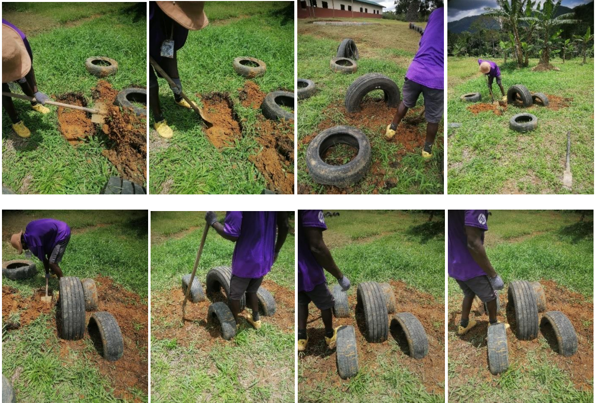
Ilustración 175: Colocación y enterramiento ruedas elefante. Fuente: Propia.
