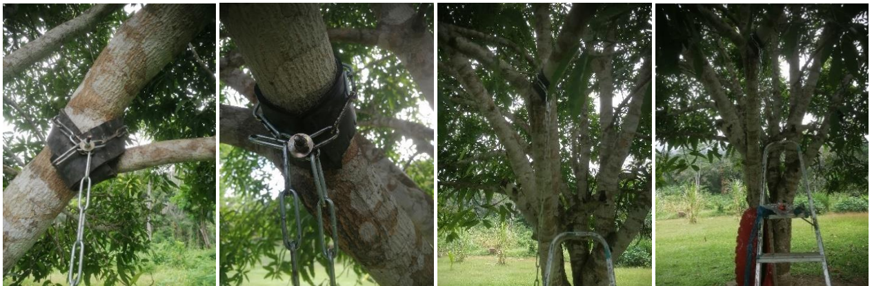
Ilustración 195: Incorporación de refuerzo a columpios del Hogar. Fuente: Propia.
