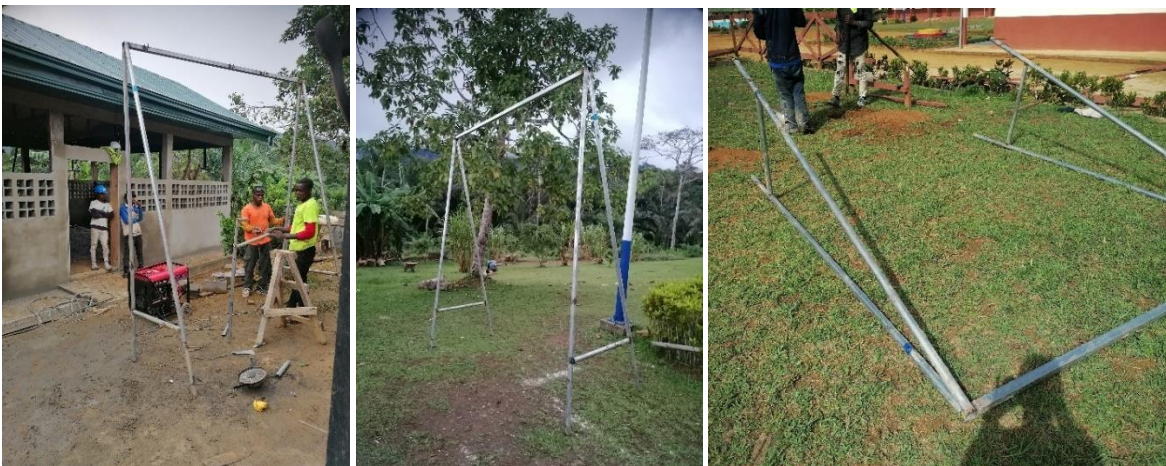
Ilustración 88: Soldadura estructura. Fuente: Propia.
