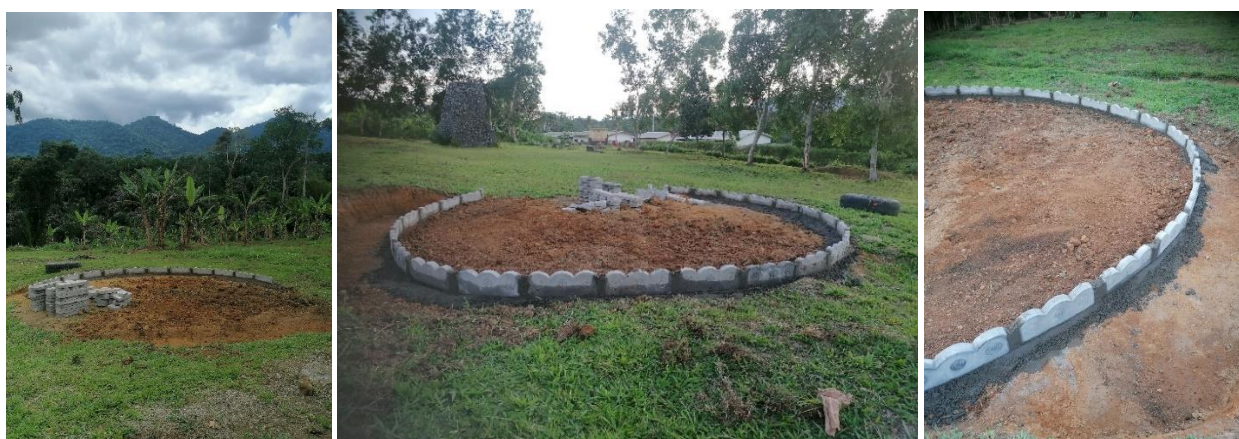
Ilustración 70: Fijación de ladrillos decorativos. Fuente: Propia.
