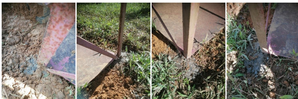
Ilustración 163: Colocación ruedas, estantería y cimentación. Fuente: Propia.
