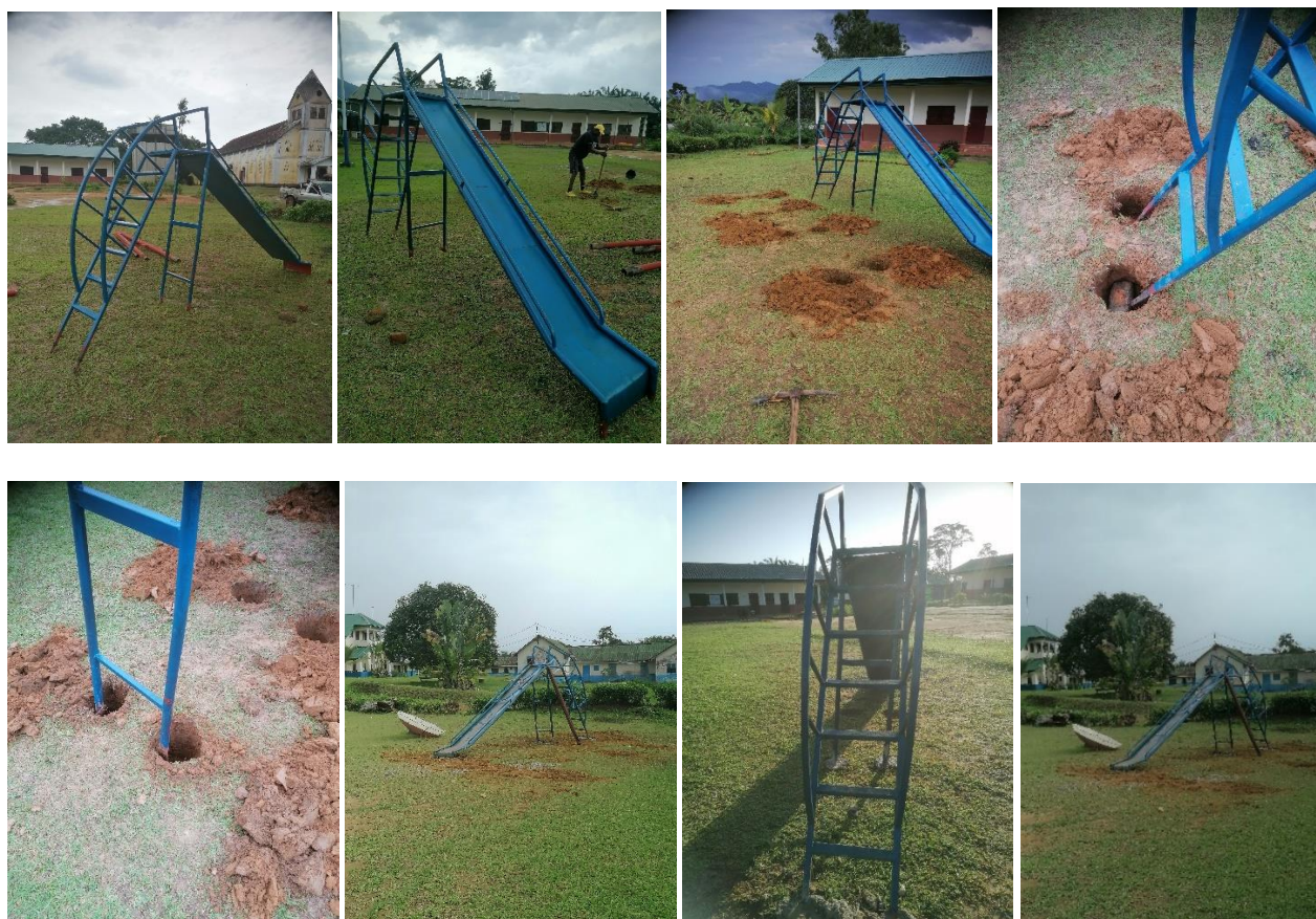
Ilustración 130: Cimentación tobogán. Fuente: Propia.
