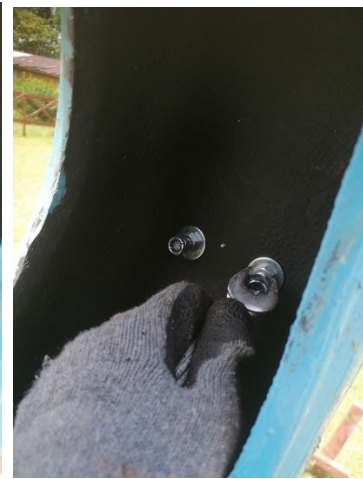
Ilustración 92: Unión primera fila de ruedas a estructura. Fuente: Propia.
