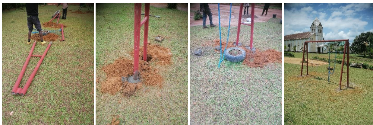
Ilustración 120: Cimentación columpios primaria. Fuente: Propia.
