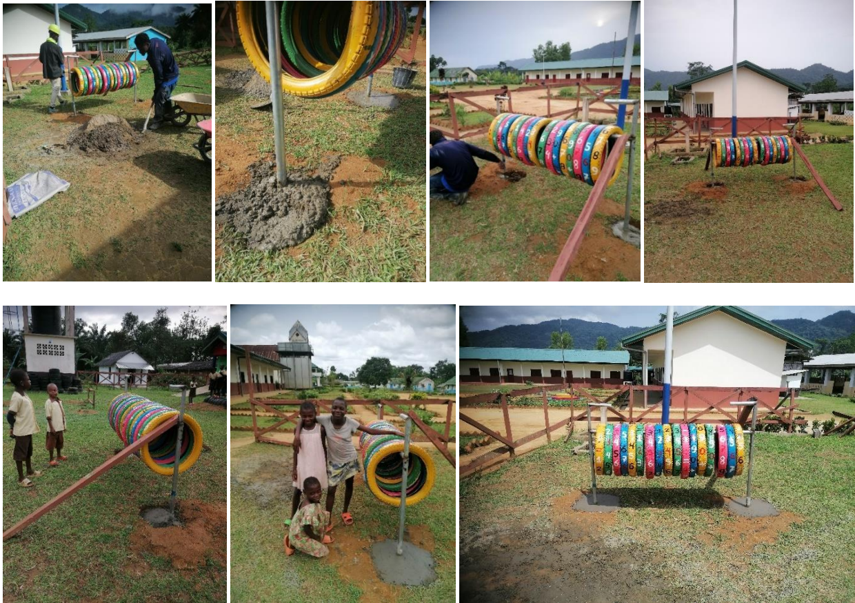
Ilustración 84: Cimentación estructura calculadora. Fuente: Propia.
