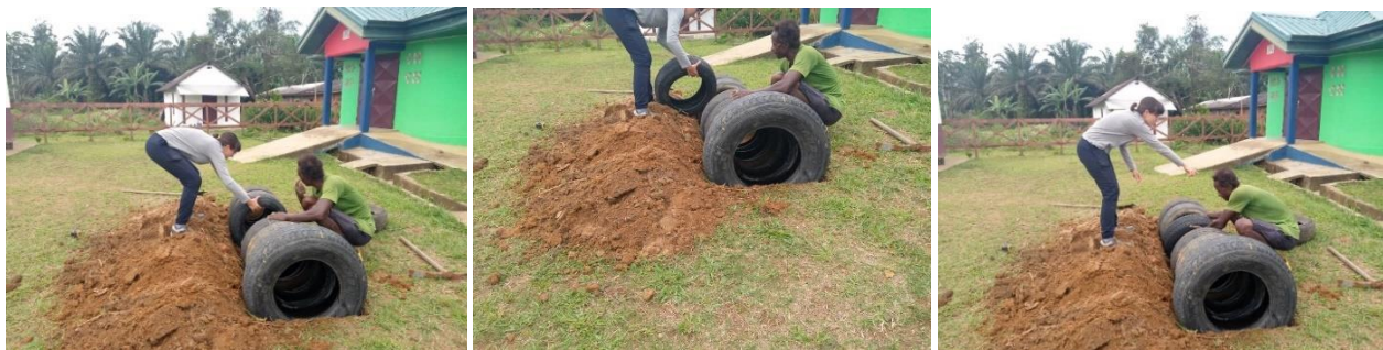
Ilustración 100: Proceso de cavar y enterrar las ruedas del gusano. Fuente: Propia.
