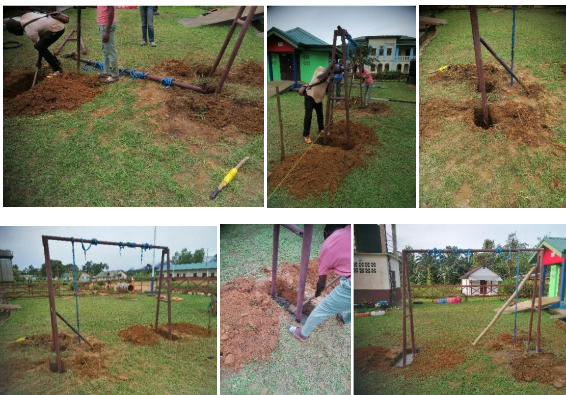
Ilustración 110: Cimentación columpios maternelle. Fuente: Propia.
