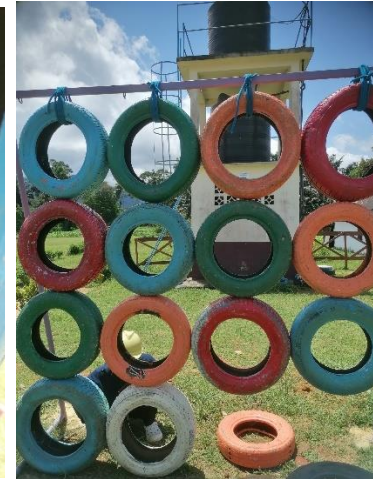
Ilustración 92: Unión primera fila de ruedas a estructura. Fuente: Propia.
