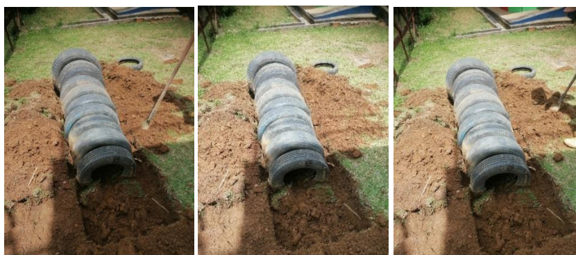
Ilustración 102: Cavado de zanja en la nueva ubicación del gusano. Fuente: Propia.
