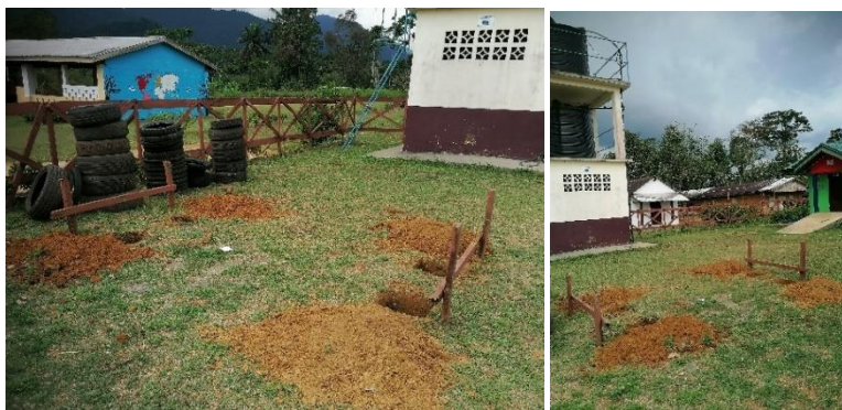
Ilustración 89: Cavado zanjas estructura. Fuente: Propia.
