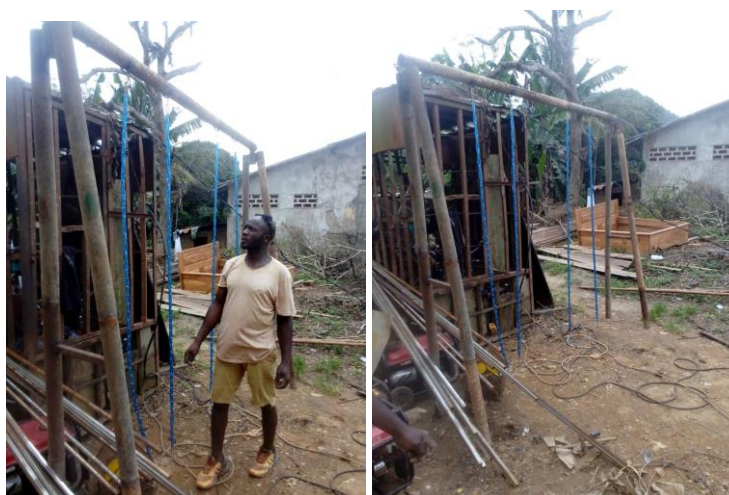
Ilustración 119: Proceso soldadura columpios. Fuente: Propia.
