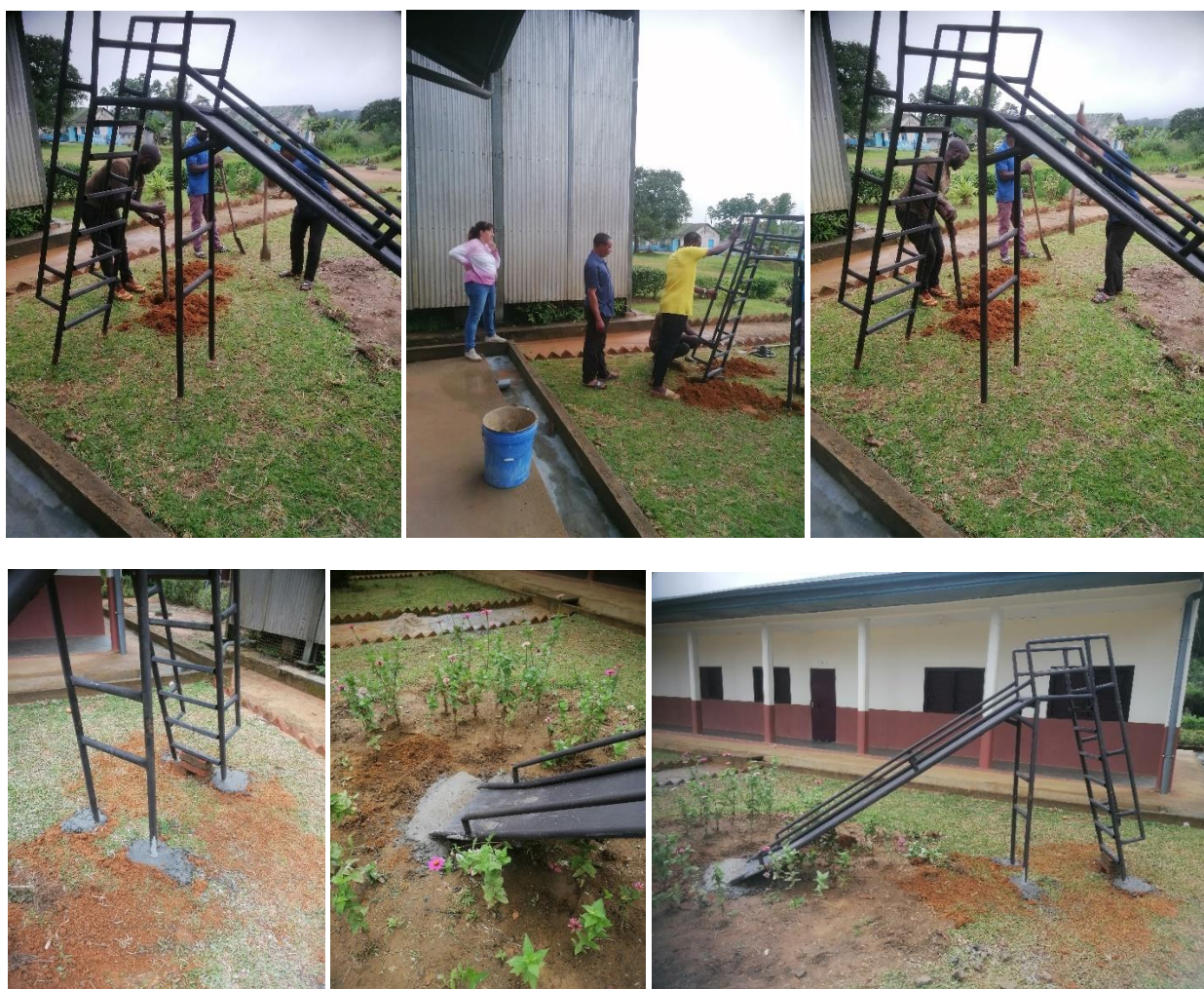
Ilustración 135: Cimentación tobogán 2. Fuente: Propia.
