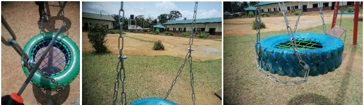
Ilustración 123: Fijación asientos columpios. Fuente: Propia.
