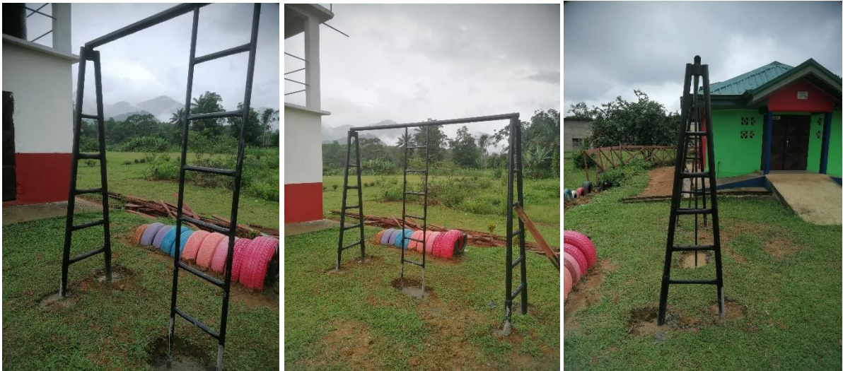
Ilustración 96: Fijación nueva estructura escalada. Fuente: Propia.
