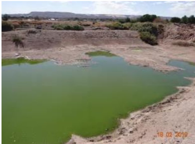
Figura 29: Fotografía de una de las piscinas de infiltración de la EDAR actual. (Fuente: SNIFA, 2023).
