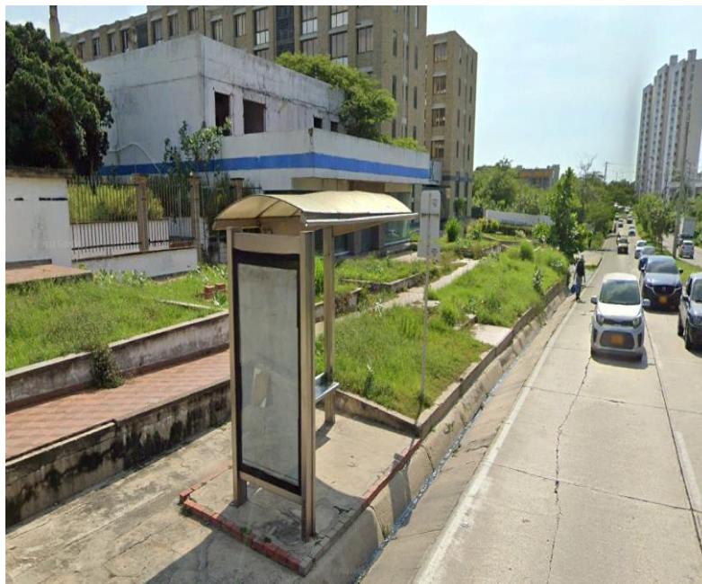
Ilustración 34. Estructuras de drenaje longitudinal aferentes al sitio de intervención
