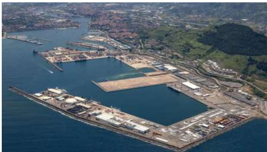
Il·lustració 2.8 Terminal contenidors Bilbao (Port Bilbao) (Autoridad Portuaria de Bilbao, 2023a)
