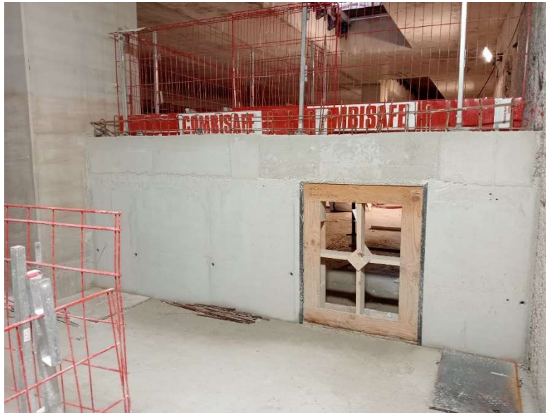
Figure 37. Mannequin voile cage 7
