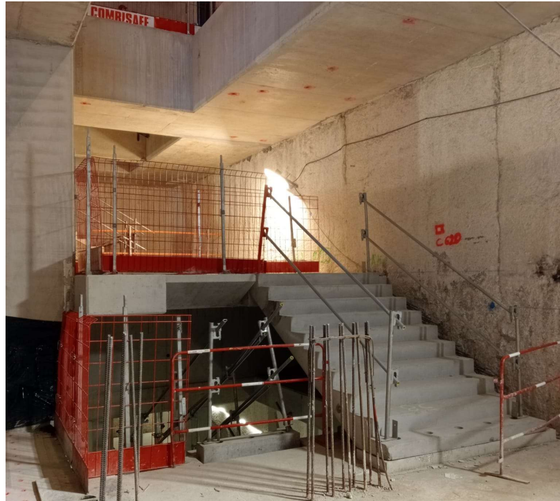
Figure 74. Pose petite volée 8C
