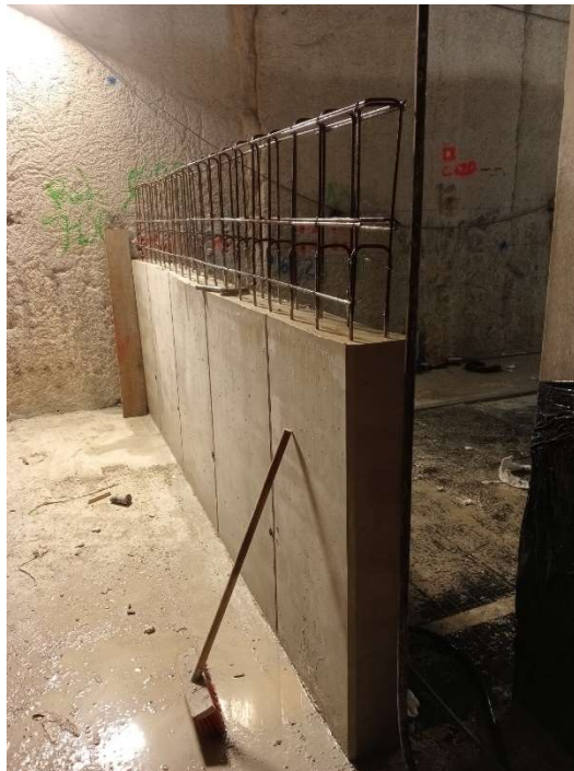
Figure 64. Voile sous palier cage 8
