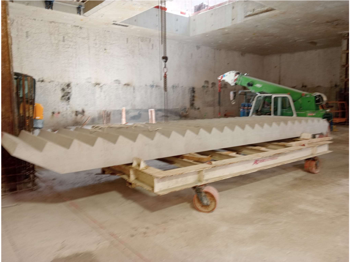
Figure 65. Chariot avec volée 10D
