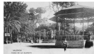
Fig.18. Vista del pabellón de música de la Glorieta, construido en 1903
