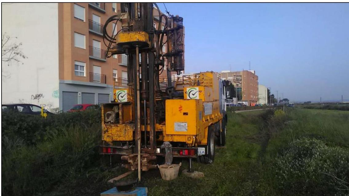
Figura 5. Realización de sondeo por equipo TP-50/400 sobre camión.
