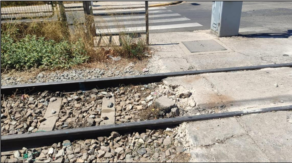
Fotografía 8. Detalle traviesas de hormigón prefabricado, costado sentido Aeroport.
