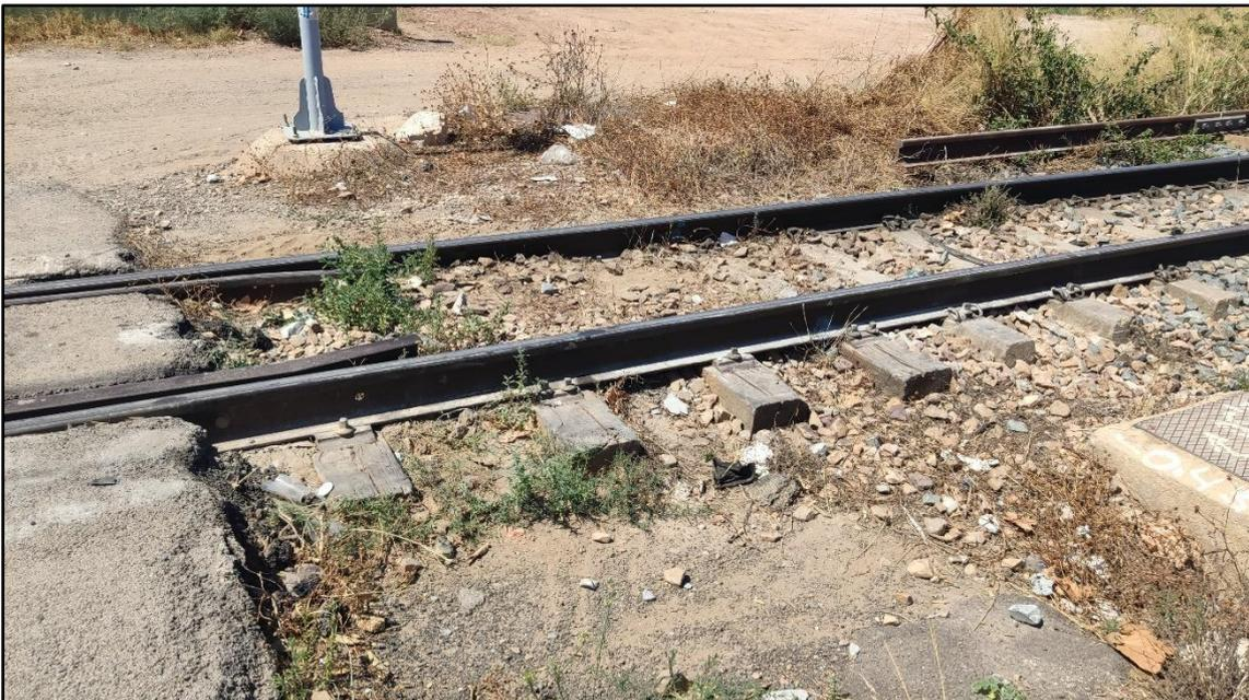
Fotografía 7. Detalle traviesas de madera y de hormigón prefabricado, costado sentido Rafelbunyol.
