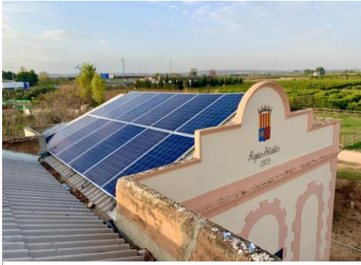
ILUSTRACIÓN 19. INSTALACIÓN PLACAS FOTOVOLTAICAS.
