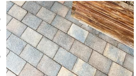
ENCUENTRO TIERRA MORTERENCA-BALDOSA FENOLLAR (LA QUE SEA 7 CM. ESPESOR)
