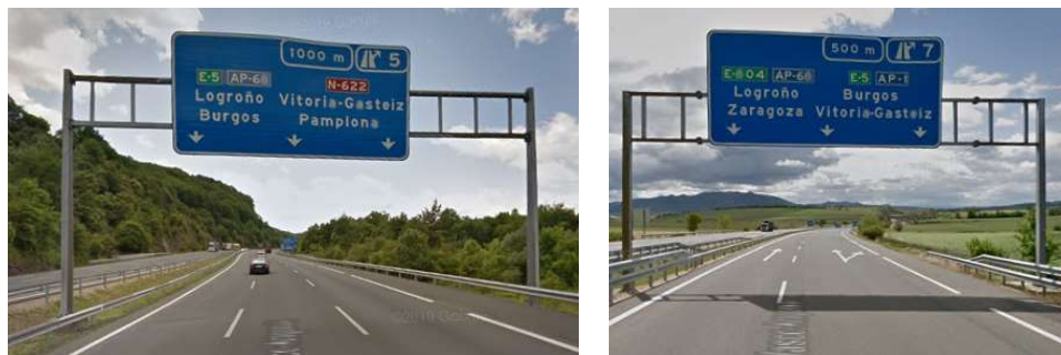
Fig. II-6. Pórticos siguiendo el borrador de 1991 en servicio. Nótese que «Vitoria-Gasteiz» cruza la frontera entre subcarteles virtuales establecida por la flecha F-1 del centro, no respetando las indicaciones del borrador. Hoy han sido sustituidos por otros según la norma vigente de 2014, aunque obviando el carril bífido y por tanto contraviniendo de nuevo disposiciones, en este caso en cuanto a duplicación de destinos. Salidas 5 y 7 de la AP-68, sentido sur. Google Street View
