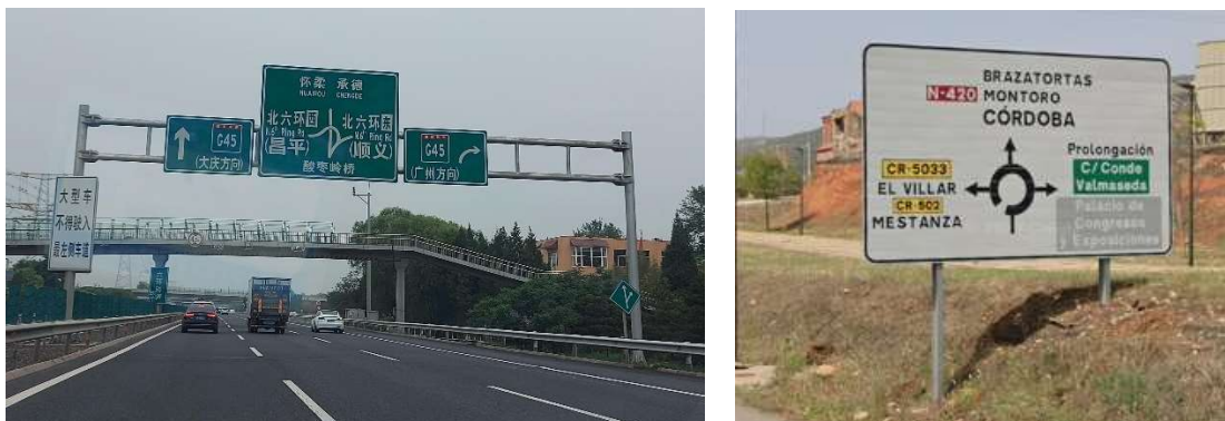
Fig. I-18. Cartel croquis junto a carteles flecha única; señalización de glorieta con croquis. S11 norte, nudo con el sexto anillo de Pekín (北六环路) y la G45, China; N-420 oeste, PK 158+300, España. Elaboración propia; Google Street View
