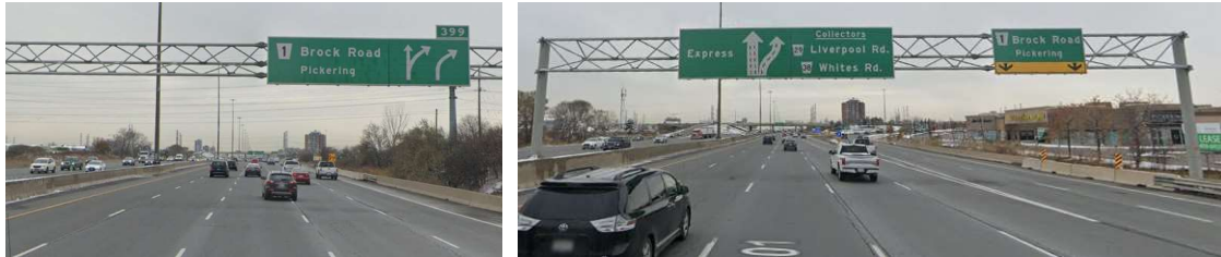
Fig. II-51. Preseñalización y señalización inmediata de carriles bífidos, con flechas bicéfalas y luego carteles diagramáticos y flecha abajo. Salida 399 de la Highway 401, sentido oeste. Google Street View
