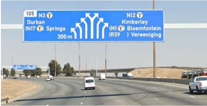
Fig. II-63. Salida en curva con carril bífido directo y tres carriles dedicados, señalizada según el Manual . Salida 105 de la N12, sentido sur, Sudáfrica. Google Street View
