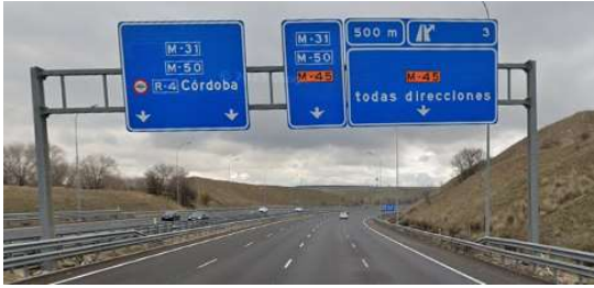
Fig. III-4. Preseñalización de la salida 31 de la M-31, sentido sur. Google Street View
