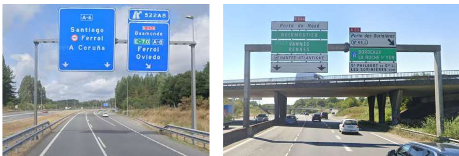
Fig. I-14. Conjuntos de carteles flecha abajo en pórticos. A-6 norte, salida 522AB, España; N844 sentido horario, salida 48b, Francia. Google Street View
