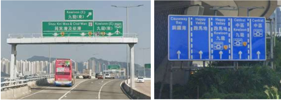
Fig. II-55. A la izquierda, pórtico con apilamiento de carteles y la duplicación del destino «Kowloon (E) / 九龍(東)» ante carril bífido directo; a la derecha, cartel lateral –con exceso de información– a la inglesa. Salida 5 de la Route 4, sentido oeste; proximidades de la salida 7 de la Victoria Park Road, sentido oeste. Google Street View
