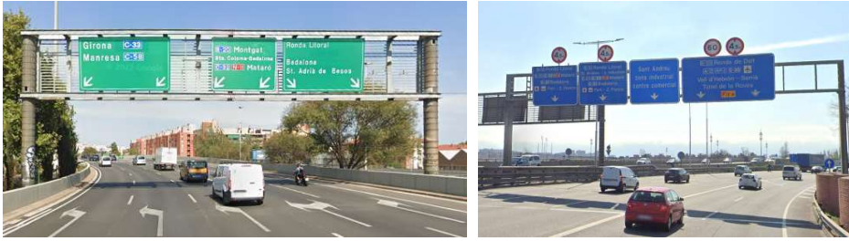
Fig. II-15. Diferencias en diseño de carteles en ramales con carriles bífidos de las Rondes. Google Street View . A la izquierda, pórtico muy similar a los carteles del tronco, empleando el verde, la tipografía Helvetica y flechas lineales; señala el carril bífido con más flechas que carriles; a la derecha, pórtico mucho más cercano a la 8.1-IC pese al empleo de Helvetica y la profusión de destinos típica de las Rondes, en este caso la divergencia se señala duplicando destinos, como indica la 8.1-IC. Respectivamente: ramal de la B-20 sentido este hacia la B-10, dentro del Nus de la Trinitat ; salida de la C-58 sentido sur hacia el ramal de Sant Andreu del Nus de la Trinitat .
