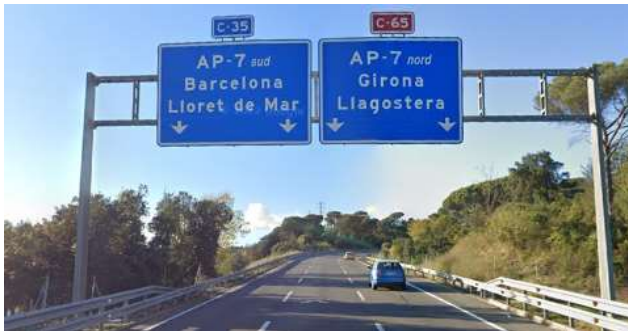
Fig. II-17. Preseñalización del nacimiento de la C-35 desde la C-65, sentido oeste. El carril bífido es el central. Nótese cómo el uso de carteles de dirección propia elimina indicaciones de distancia o número de salida y confunde al no especificar en cuál carretera se circula y a cuál se accede. Google Street View
