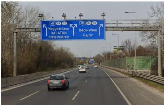
Fig. II-31. Bifurcación con carril bífido indirecto señalizada con cartel flecha por carril. M1 en el nudo con la M7, sentido oeste. Google Street View .
