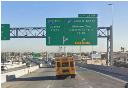
Fig. III-15. La diferencia de tamaño entre el autobús escolar y el cartel ilustra cómo el diseño de las señales flecha por carril puede resultar en carteles muy grandes. I-278 este, salida 35 A-B, Nueva York, EE UU. Google Street View
