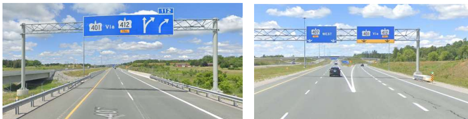
Fig. II-52. El sistema de Ontario puede inducir a confusión. Nótese cómo en la preseñalización, cuando todavía no ha comenzado el carril de deceleración, un conductor no familiarizado con los carteles podría pensar que se preseñaliza una salida directa a izquierdas hacia la Highway 401, curvándose los carriles de dirección propia a la derecha, cuando ocurre lo contrario. Salida 312 de la Highway 407, sentido oeste. Google Street View
