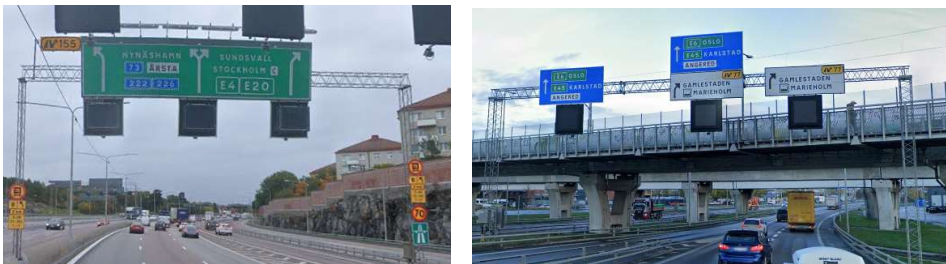
Fig. II-38. A la derecha, cartel flecha por carril señalizando un carril bífido; a la izquierda, un ejemplo de las soluciones peculiares cuando no se usan carteles flecha por carril: carteles flecha arriba apilados individualmente y con duplicación de destinos. Respectivamente: E4, salida 155, sentido norte; E45, salida 77, sentido norte. Google Street View
