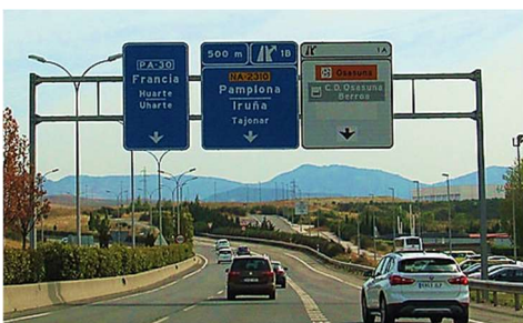
Fig. I-4. Pórtico donde se observan señales de preseñalización y de dirección. De izquierda a derecha: cartel de dirección propia, cartel de preseñalización y cartel de salida inmediata. Wikimedia Commons
