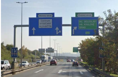
Fig. II-37. Carril bífido directo señalizado combinando sistema flecha por carril con flecha arriba. Městský okruh de Praga, salida hacia la D0, sentido horario. Google Street View
