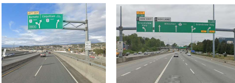
Fig. II-53. Preseñalización con carteles flecha por carril, ante salidas directas y carriles bífidos. Nótese la curvatura de las flechas en el cartel de la izquierda. Salida sin numerar de la calzada colectora de la Trans-Canada Highway, sentido oeste, a la altura de la salida 44; salida 28B de la Trans-Canada Highway, sentido oeste. Google Street View
