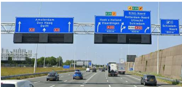
Fig. III-18. Obsérvese la flecha abreviada en el cartel flecha arriba de la izquierda, permitiendo que hasta dos destinos puedan ubicarse entre las flechas exteriores. Salida 10 de la A4, sentido norte, Países Bajos. Google Street View
