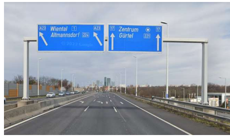
Fig. II-34. Preseñalización y señalización de salida inmediata. Nótese que esta última se ubica varias decenas de metros antes de la escisión del carril bífido. Ramal desde la salida «Wienn Altmannsdorf» de la A2 hacia la B17, sentido norte. Google Street View
