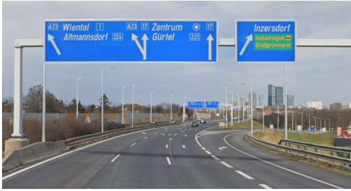
Fig. II-34. Preseñalización y señalización de salida inmediata. Nótese que esta última se ubica varias decenas de metros antes de la escisión del carril bífido. Ramal desde la salida «Wienn Altmannsdorf» de la A2 hacia la B17, sentido norte. Google Street View
