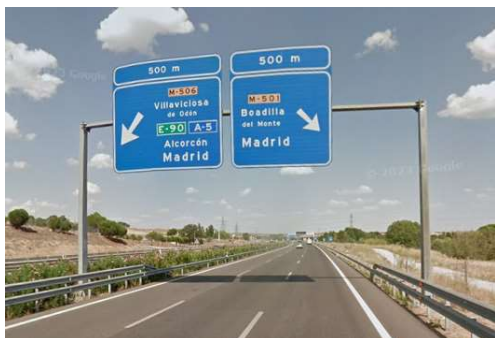
Fig. II-14. Carteles de la Comunidad de Madrid señalizando el carril bífido de manera completamente arbitraria. Salida 10 de la M-501, sentido este. Google Street View
