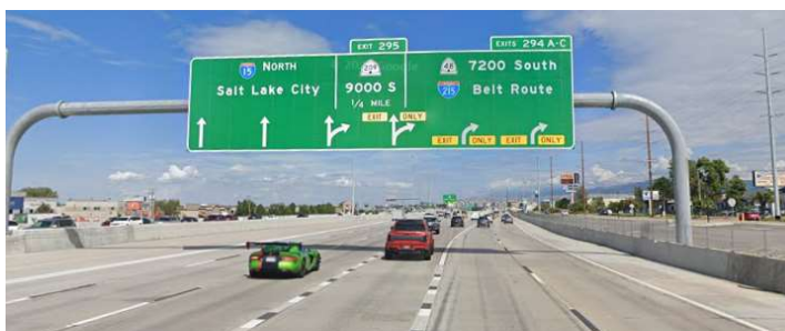
Fig. II-44. Uso simultáneo de dos flechas bicéfalas para señalar y preseñalar una pareja de carriles bífidos en sucesión, contraviniendo el MUTCD. Salida 294A-C de la I-15, sentido norte. Google Street View
