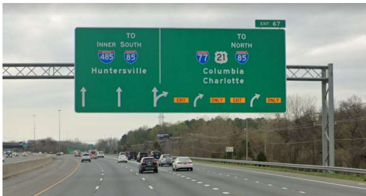
Fig. II-43. Cartel flecha por carril en la salida 67 de la I-485, sentido horario. Nótese que no se cumple la recomendación limitando el número de destinos. Google Street View
