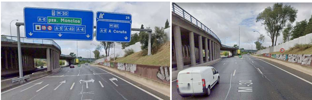
Fig. II-16. A la izquierda, señalización en la salida 25 de la M-30, sentido antihorario, mostrando al carril bífido como únicamente de dirección propia; a la derecha, la escisión unos metros después. No obstante, nótese el descentrado en la flecha F-1 del cartel de salida inmediata, no repetido en los otros carteles que señalizan carriles bífidos en la circunvalación madrileña. Este error de diseño seguramente fue inducido por la presencia del carril bífido. Préstese atención también a las marcas viales, donde las flechas sí indican la opcionalidad del carril. Google Street View
