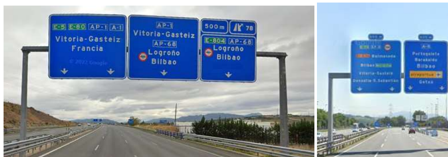
Fig. II-13. A la izquierda, carteles de la Diputación Foral de Álava siguiendo los postulados de la norma 8.1-IC, duplicando destinos; a la derecha, señales de la Diputación Foral de Gipuzkoa con más flechas que carriles y empleando gratuitamente carteles de dirección propia. Respectivamente: salida 78 de la A-1, sentido norte; bifurcación sin numerar inmediata a la salida 130 de la A-8, sentido este. Google Street View
