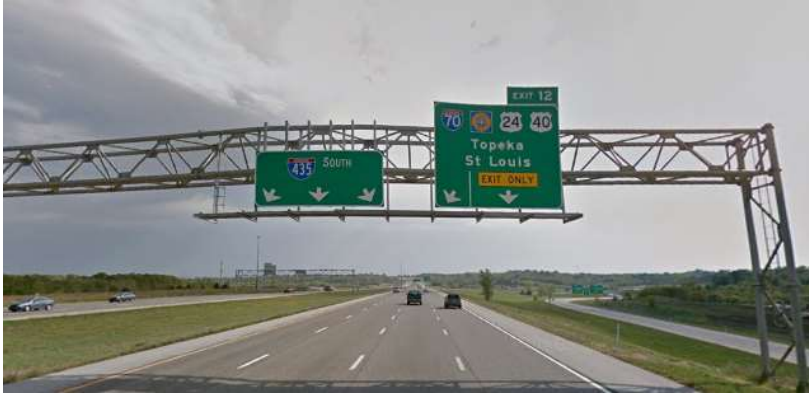
Fig. II-47. Cartel con dancing arrows en la salida 12 de la I-435, sentido sur. En este caso, el carril bífido es preseñalizado con las flechas diagonales interiores. Google Street View
