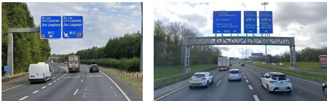
Fig. II-22. Señalización irlandesa, con duplicación de destinos; a la izquierda, salida inmediata en carril bífido directo; a la derecha, preseñalización en carril bífido indirecto. Respectivamente: M11, salida 17, sentido norte, y M1, salida 1, sentido sur. Google Street View
