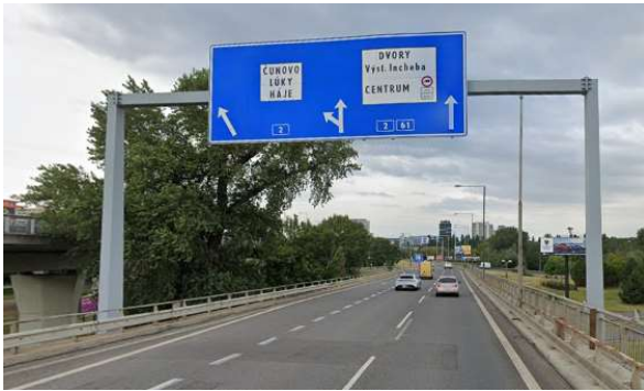
Fig. II-30. Preseñalización de carril bífido directo. Nudo de la D1 en Ovsište, sentido oeste. Google Street View
