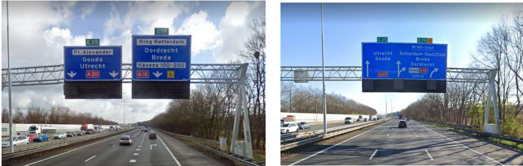
Fig. II-32. A la izquierda, pórtico según la antigua normativa no señalizando que el carril central permite también acceder a la salida por ser bífido directo; a la derecha, el mismo pórtico tras ser renovados los carteles. Nótese el uso de flechas alargadas en este último, por tratarse de una preseñalización. A20 sentido oeste en el nudo Terbregseplein con la A16. Google Street View
