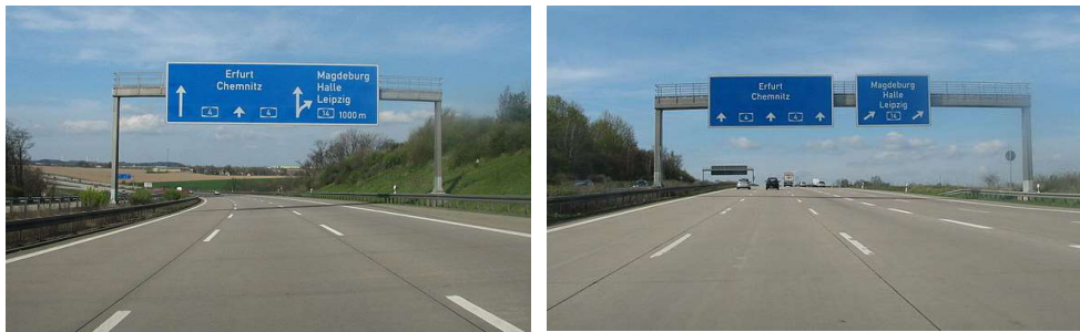
Fig. II-27. A la izquierda, señalización con un cartel flecha por carril por no disponer todavía de carriles dedicados; a la derecha, señalización de la misma salida unos metros después con carteles flecha arriba, por ya existir carriles para la misma. Salida 76 «Autobahndreieck Nossen» de la A4 en el nudo con la A14, sentido este. Wikimedia Commons .
