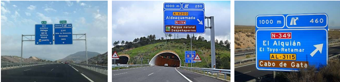
Fig. I-3. Diferentes estructuras portantes para señalización de orientación. De izquierda a derecha: pórtico, banderola y cartel lateral. Emilio J. Rodríguez Posada, Wikimedia Commons
