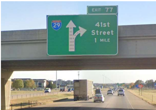
Fig. II-46. Cartel diagramático preseñalizando carril bífido directo. Salida 77 de la I-29 sur. Google Street View
