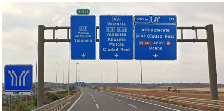
Fig. III-3. Preseñalización de la salida 177 de la A-3, sentido este. Incluso omitiendo destinos, el cartel central contiene la friolera de siete líneas. Hasta empleando la cifra favorable de 333 ms por palabra se requiere de más de 5 segundos para leer este pórtico, algo inasumible. Google Street View
