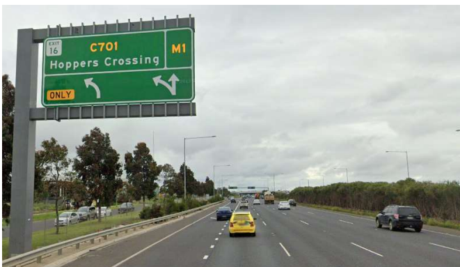
Fig. II-61. Preseñalización indicando sólo uno de los cuatro carriles de tronco. Salida 16, M1 sentido oeste. Google Street View
