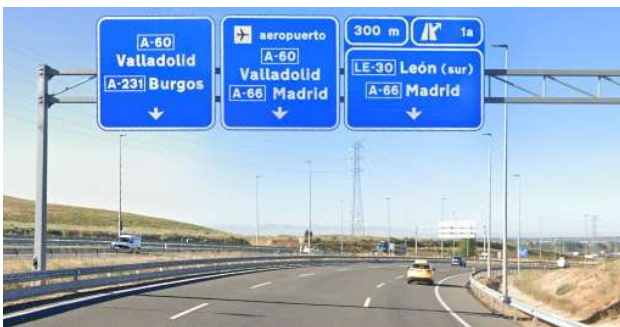
Fig. III-6. Preseñalización de la salida 1A de la LE-30, sentido sur. Google Street View
