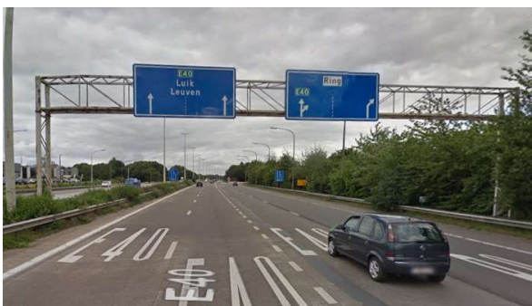
Fig. II-36. Combinación entre carteles flecha arriba y flecha por carril. Nótesen las líneas intermitentes separando carriles dentro de cada uno. Salida «Sint-Stevens-Woluwe» de la E40, sentido este. Google Street View .
