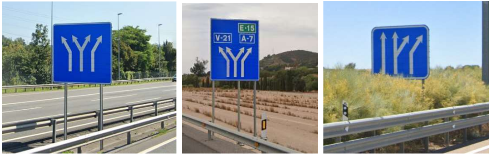
Fig. II-12. Variantes de la señal S-63, con carril bífido, anteriores al borrador del Catálogo. Nótese el útil añadido de los cajetines o el empleo de flechas verticales en el segundo y tercer ejemplos, lo cual no se prevé en el borrador. A-8 este, salida 130; A-7 sur, salida 51; A-66 sur, salida 205A. Google Street View
