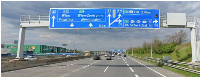
Fig. II-35. Doble preseñalización de carril bífido. A2 sentido norte, preseñalización de la salida «Knoten Schwechat». Google Street View
