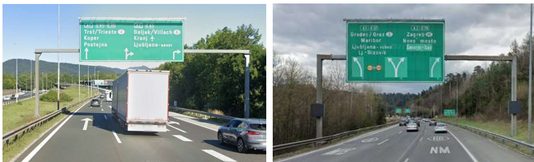
Fig. II-29. De izquierda a derecha, carteles de preseñalización flecha por carril para carril bífido directo e indirecto. Respectivamente, salida 31 «razcep Malence» de la A1, sentido este; salida 36 «razcep Kozarje» de la A2, sentido oeste. Google Street View
