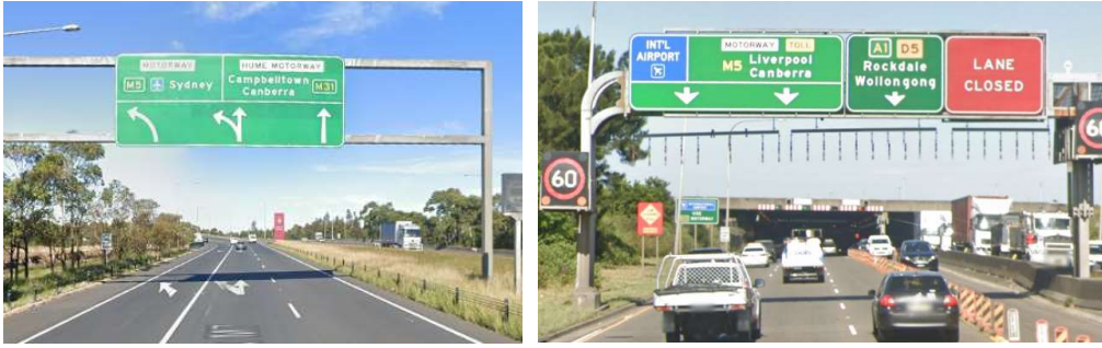
Fig. II-58. Uso de carteles flecha por carril y flecha abajo para carriles bífidos, indicando la opcionalidad con la división de las cajas sobre las flechas. La señal de la derecha se encuentra a cierta distancia de la escisión del carril bífido, mientras que la de izquierda es mucho más próxima. Bifurcación del final de la M7 sentido sur en el nudo Roden Cutler, bifurcación del final de la M1 sentido oeste en el nudo con M5 y A1. Google Street View
