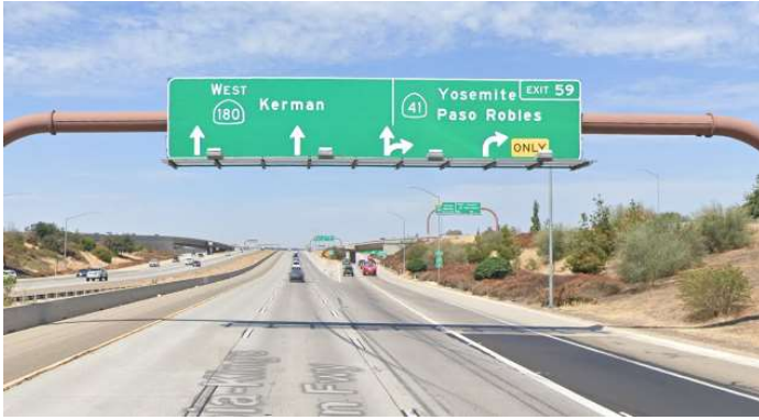
Fig. II-45. Uso de flechas incumpliendo el tamaño mínimo del MUTCD para ahorrar espacio en el cartel. Salida 59 de la CA-180, sentido oeste.
