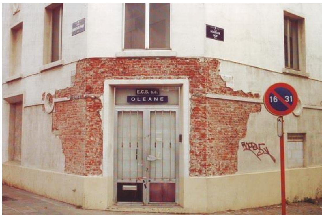
Fig.6. Almarcegui, L. Retirando el cemento de la fachada ,1999
