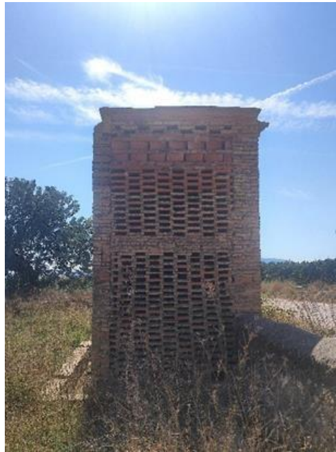
Fig. 2. Construcción de caña y ladrillo, llamada "cebera" dedicada antiguamente a almacenar las cebollas para su secado.
