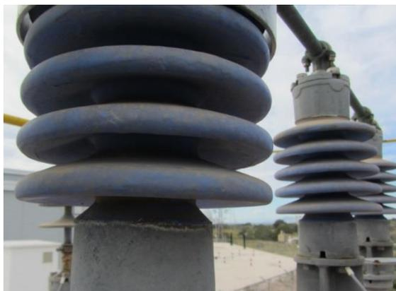
Figura 22. Aisladores en el montaje ensayado.
