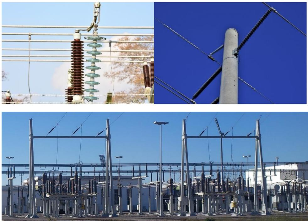
Figura 6. Aisladores de porcelana, vidrio y SIR, y Pórticos subestación transformadora 132/20 kV.
