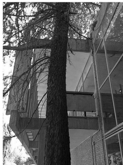
Fig. 7. Fachada norte. Terraza perimetral volada en la planta superior, y parasoles.
