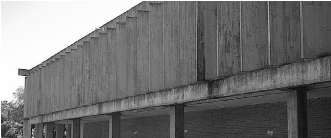
Fig. 10. Vista exterior de los parasoles de la fachada norte.
