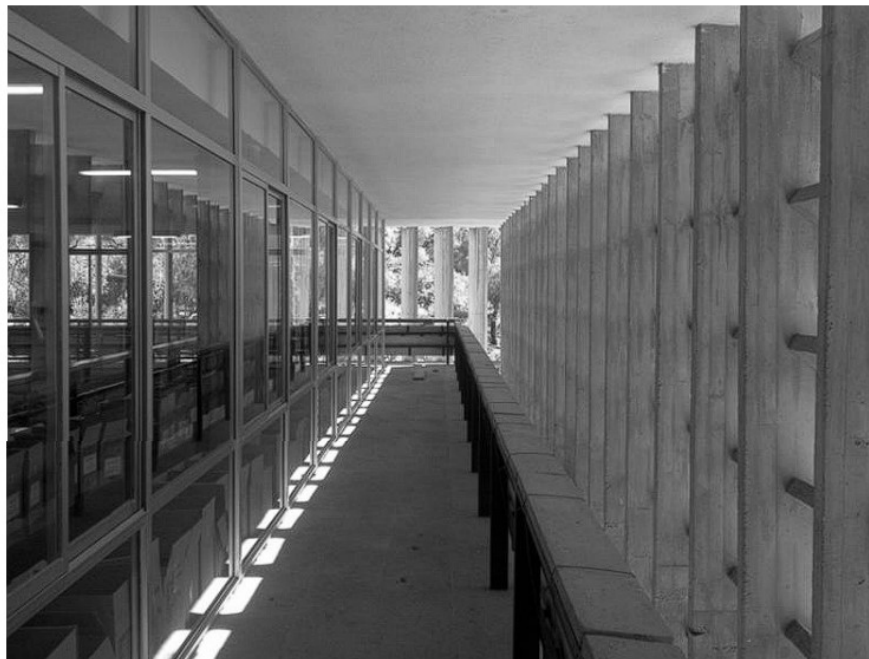
Fig. 5. Espacio intermedio entre los parasoles y la fachada sur, en la planta superior.
