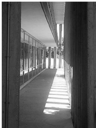
Fig. 6. Espacio intermedio entre los parasoles y la fachada sur, en la planta inferior.
