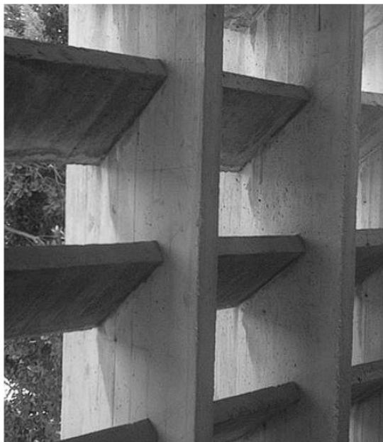
Fig. 11. Vista desde el interior de los parasoles horizontales y verticales de la fachada sur, desde la terraza perimetral de la planta superior.
