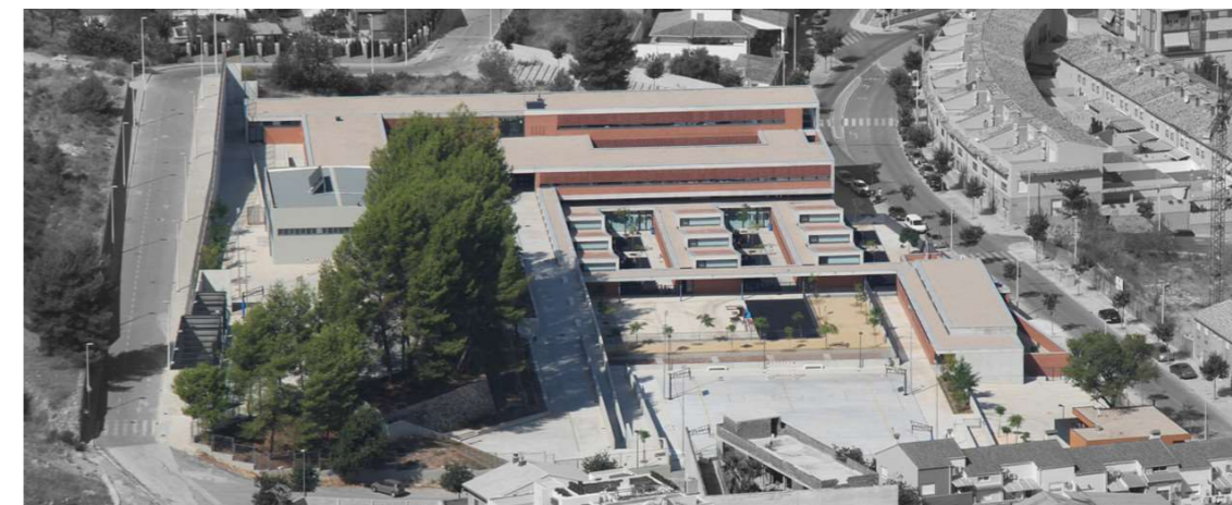
Figura 19. Vista aérea del centro. Carlos Soler Monrabal. https://www.archdaily.cl/cl/02-91564/centro-de-educacion-beato-jacinto-castaneda-fernandez-soler-monrabal-arquitectos
