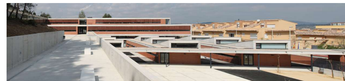
Figura 20. Vista desde la zona exterior del primer nivel. Carlos Soler Monrabal. https://www.archdaily.cl/cl/02-91564/centro-de-educacion-beato-jacinto-castaneda-fernandez-soler-monrabal-arquitectos
