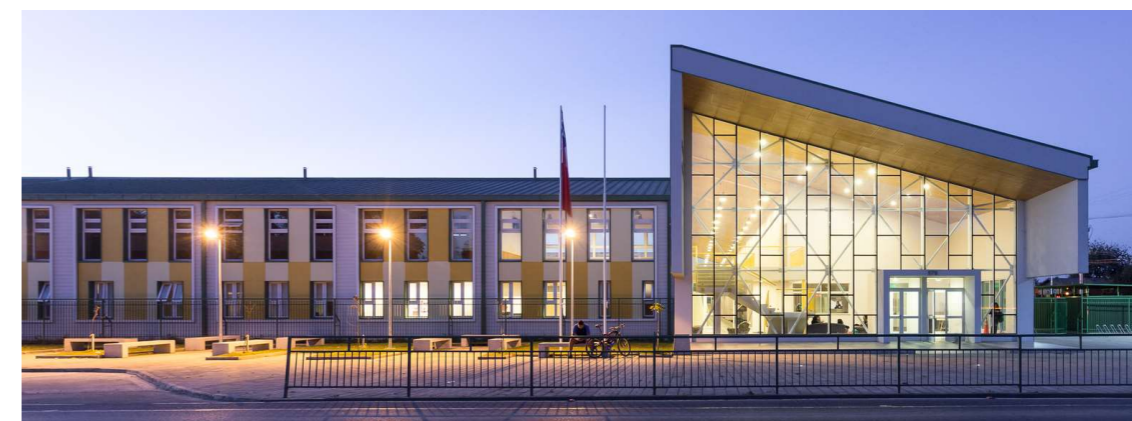
Figura 30. Alzado sur y vista de la entrada del centro. Pablo Blanco. https://www.archdaily.cl/cl/900273/colegio-de-cultura-y-difusion-artistica-de-la-union-andres-crisosto-smith
