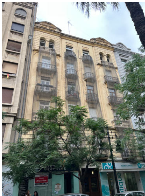
Figura 127: Edificio Avenida Regne de Valencia nº 26 Fuente: Elaboración propia
