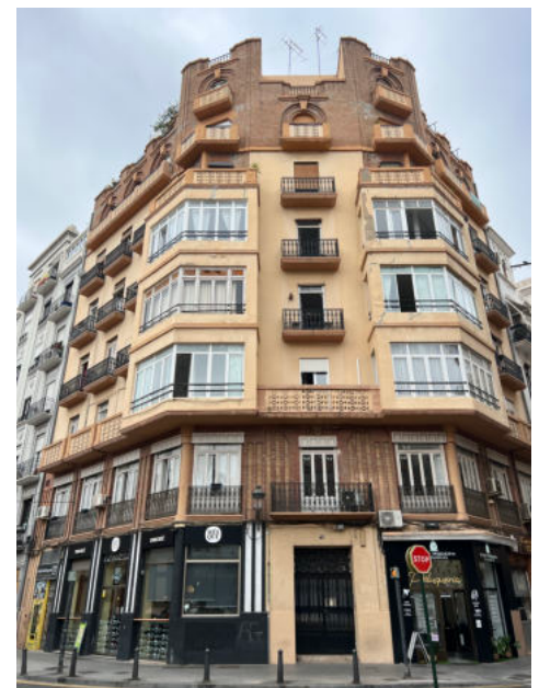
Figura 42: Edificio Calle Doctor Sumsi nº2. Fuente: Elaboración propia
