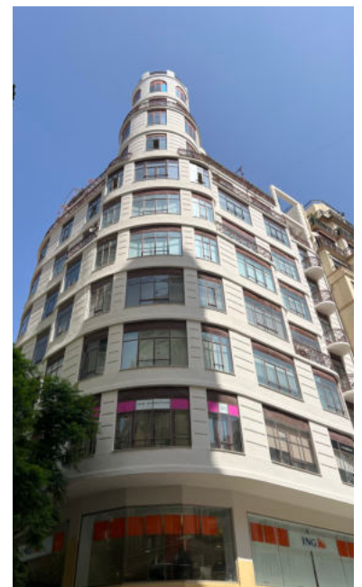
Figura 85: Edificio Calle San Vicente Mártir nº22. Fuente: Elaboración propia
