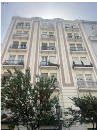
Figura 120: Edificio Calle Pedro III el Grande nº 4 Fuente: Elaboración propia
