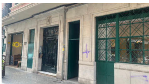
Figura 113: Edificio Calle Historiador Diago nº3 Fuente: Elaboración propia
