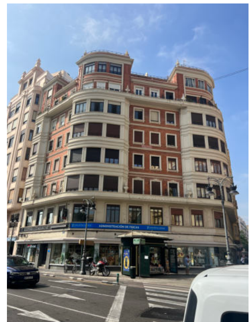
Figura 102: Edificio Calle Guillem de Castro nº55 Fuente: Elaboración propia
