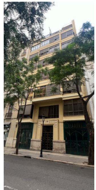
Figura 72: Edificio Calle Sorní nº42. Fuente: Elaboración propia
