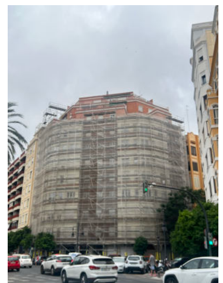
Figura 117: Edificio Avenida Jacinto Benavente nº8
