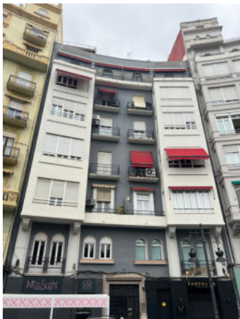
Figura 133: Edificio Plaza Cánovas del Castillo nº 9. Fuente: Elaboración propia
