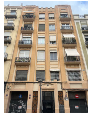
Figura 68: Edificio Calle Pedro III el Grande nº18. Fuente: Elaboración propia
