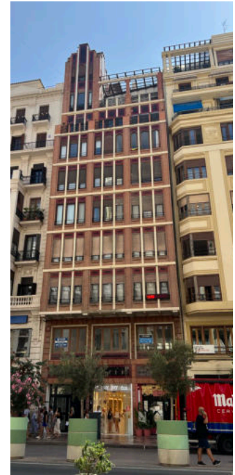
Figura 13: Edificio Cervera. Fuente: Elaboración propia
