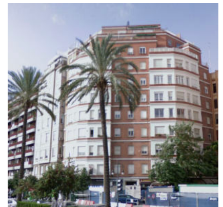
Figura 115: Edificio Avenida Jacinto Benavente nº8
