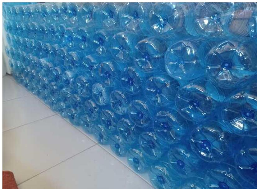
FIGURA 9: Prueba con botellas de plástico, construcción de un muro.
