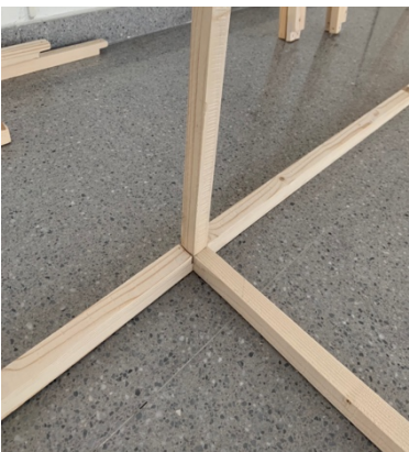
Ilustración 92. Hogar temporal. Detalle del ensamble de la estructura de madera.
