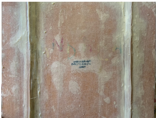
Ilustración 139. 3ª Capa. Fibra de vidrio y látex.
