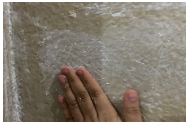
Ilustración 144. Capa de polvos de talco como protección.
