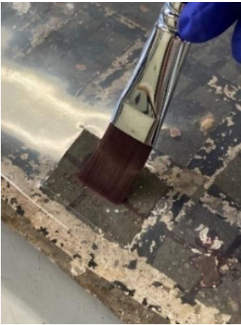
Figura 47. Barrido con brocha de cerda suave.
