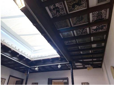
Figura 8. Disposición de los socarrats entre vigas de madera del Museo Municipal de Cerámica de Paterna.
